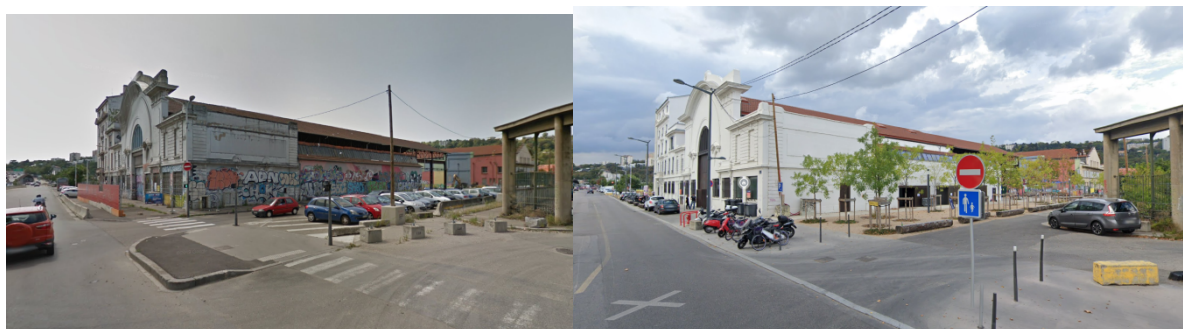
Illustration 4 : Le bâtiment photographié par Google en 2017 et en 2020
