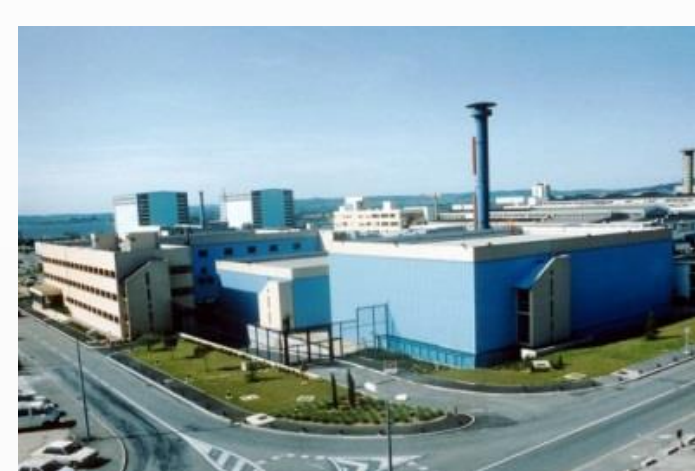
L'installation d'ATALANTE du CEA Marcoule
