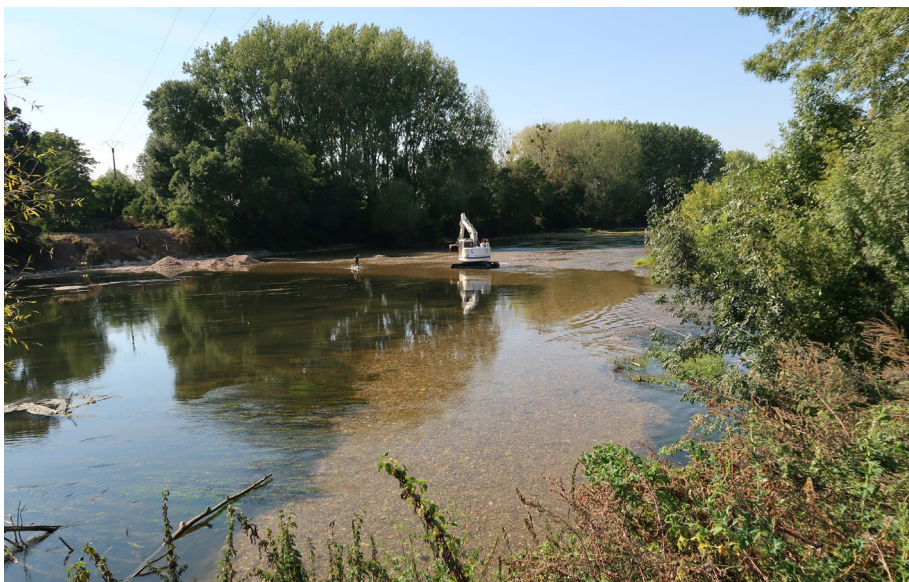
FIGURE 5 : Travaux de restauration (photo : L. Philippe).
