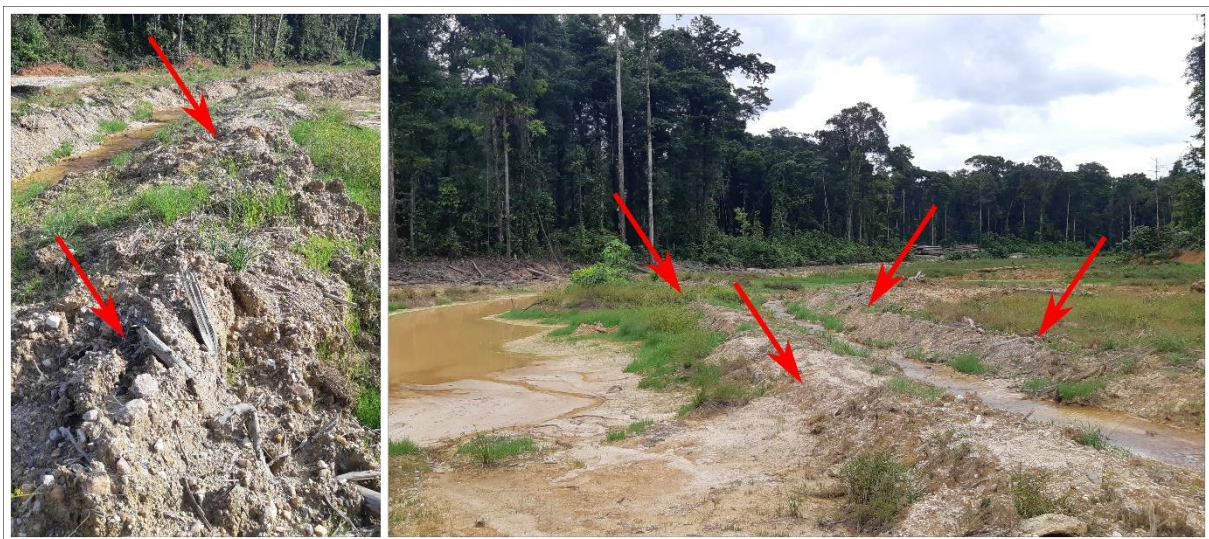
Figure 2 : Exemples de merlons disposés sur les berges de criques réhabilitées (© Melun & Le Bihan - OFB).
