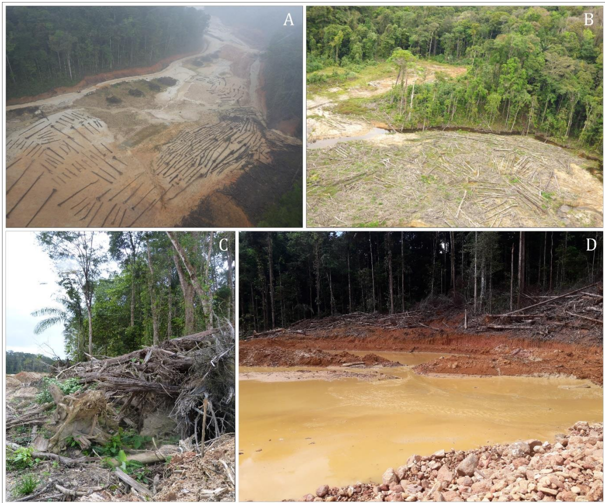
Figure 23 : Illustrations de la bonne redistribution des grumes et troncs à la surface du lit majeur préalablement exploité (A, B). Les andains établis sur les marges de la zones exploitée (C, D) doivent obligatoirement être démantelés en fin d'exploitation (© Melun & Le Bihan - OFB).
