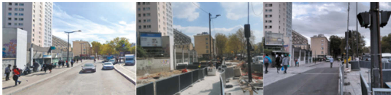
Une vue de la rue de la Chapelle à Paris, avant (septembre 2019), pendant (avril 2023) et après (septembre 2023) les travaux d'aménagements.
