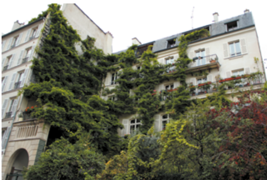
Façades végétalisées à Paris. © L. Cornier, projet ECOVILLE.
