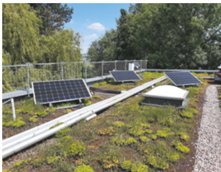
Photo de la plateforme expérimentale du Cerema montrant les deux parcelles végétalisées pourvues de panneaux photovoltaïques (toiture biosolaire).
