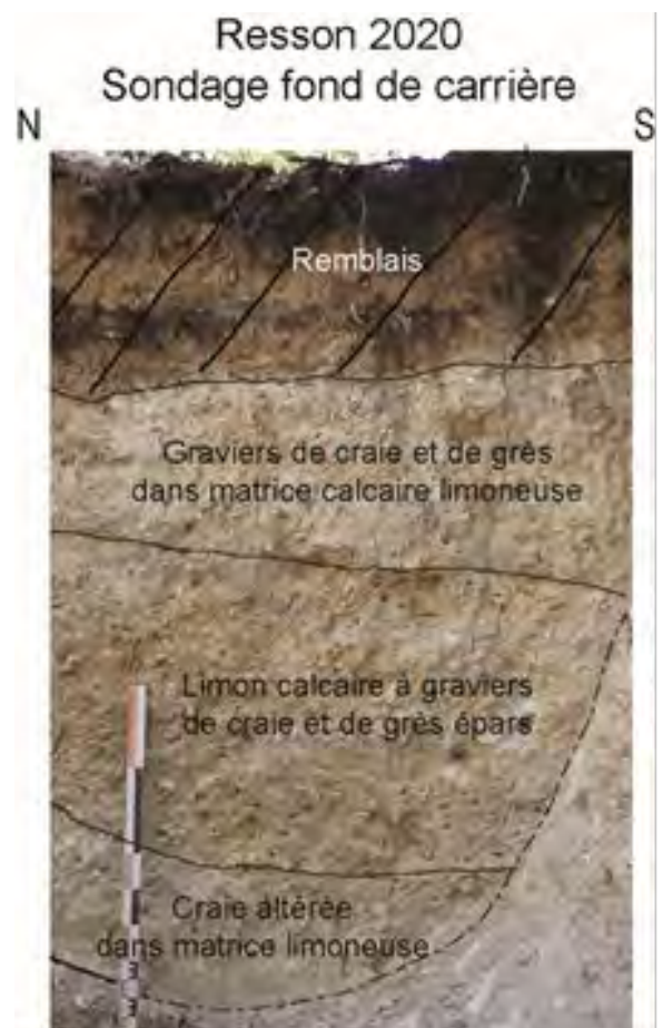
Figure 5 : coupe dans le sondage réalisé dans le front de la carrière à 4-5 m du pied de coupe sud (photo et PAO JD)
