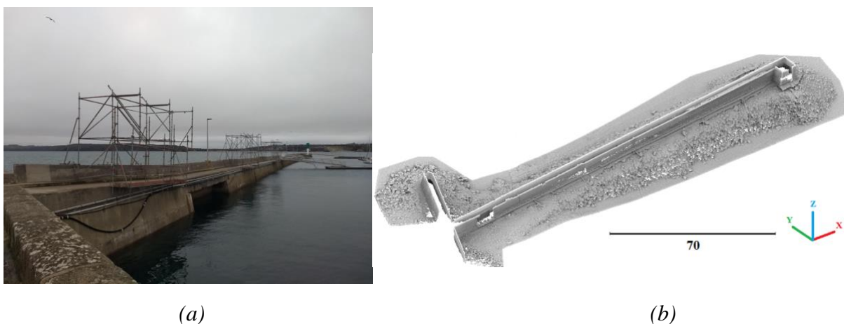
Figure 2. Données complémentaires : (a) photo prise lors de la visite du site (Source : Ingérop); (b) nuage de points 3D du môle
