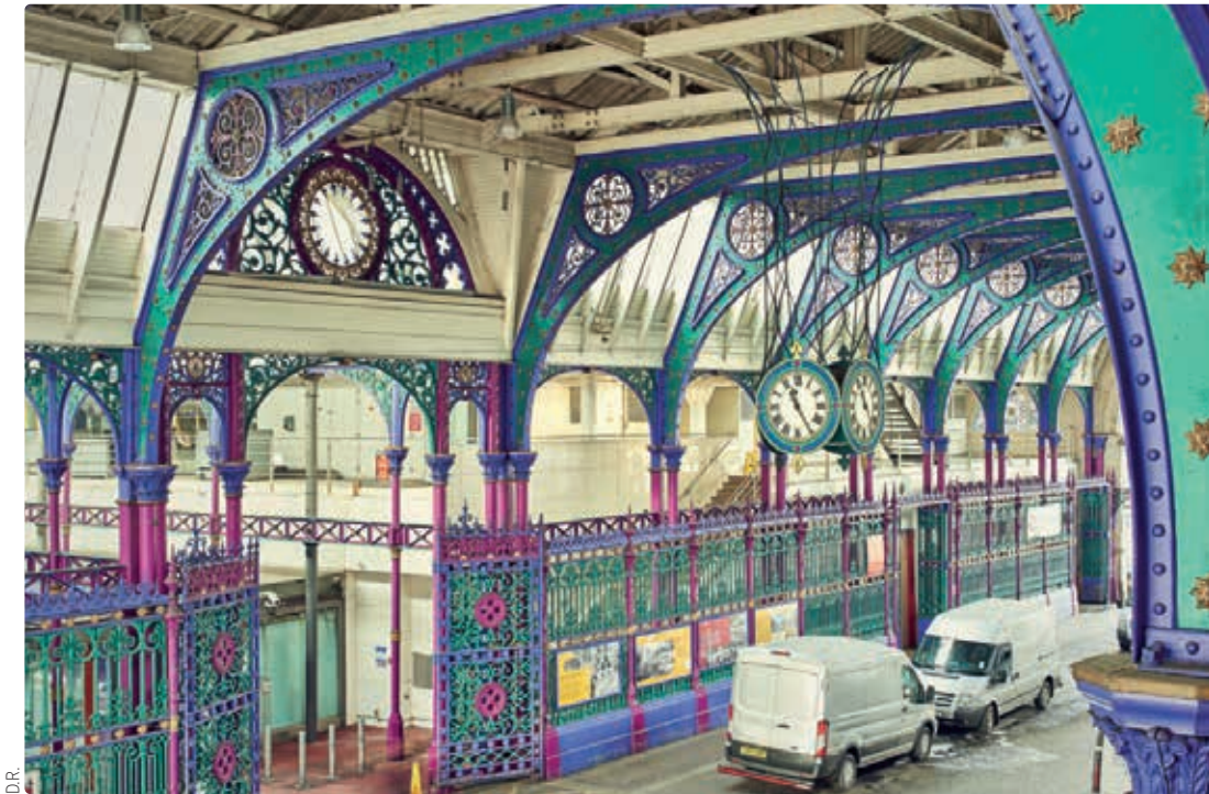
Smithfield Market, Londres, architecte Horace Jones, entr. Browne & Robinson, 1866-67. (Photo prise en 2017).
