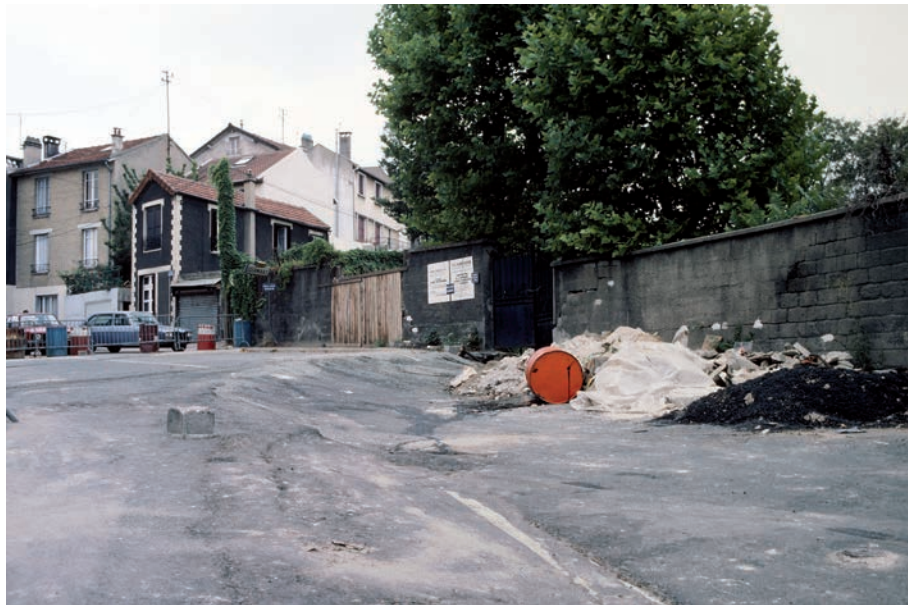
Photo 2 : Le boulevard Rodin à Meudon (92) : l'affaissement dans la carrière de craie sous-jacente s'est répercuté en surface. Cliché R. Chardon, 24 juillet 1982. Damage to the surface of Rodin Boulevard in Meudon (92), caused by subsidence in the underlying chalk quarry.
