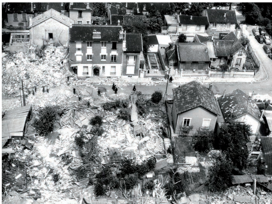
Photo 3 : Effondrement de carrière à Clamart le 1 er juin 1961 Crédits : archives municipales de Clamart. Collapse: Clamart. 1 June 1961: the roof fall of an old chalk mine wiped 23 buildings off the map.
