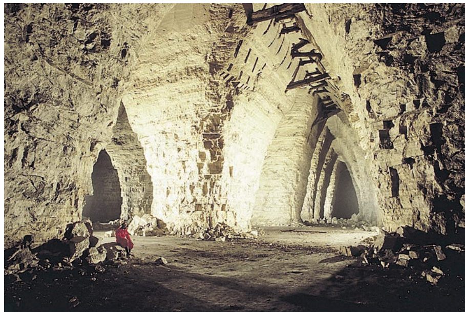
Photo 1 : Ancienne carrière de gypse Aubry-Pachot à Livry-Gargan (93). Les galeries de haute masse, de forme ogivale, se recoupent perpendiculairement laissant les piliers tournés (renforcés par des boisages en hauteur) assurer la solidité de l'ensemble. Cliché E. Gaffard.
