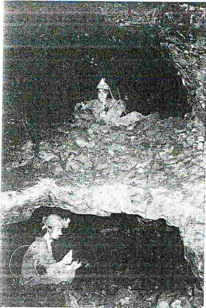
Abb. 9: Gelegentlich kam es zu zweisöhligem Abbau in Melle
