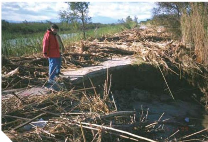
Dégâts dus à la surverse d'une digue lors de la crue des 12-13/11/1999 : importante loupe d'érosion et de glissement dans le talus aval (© E. Josse DDE 66).
