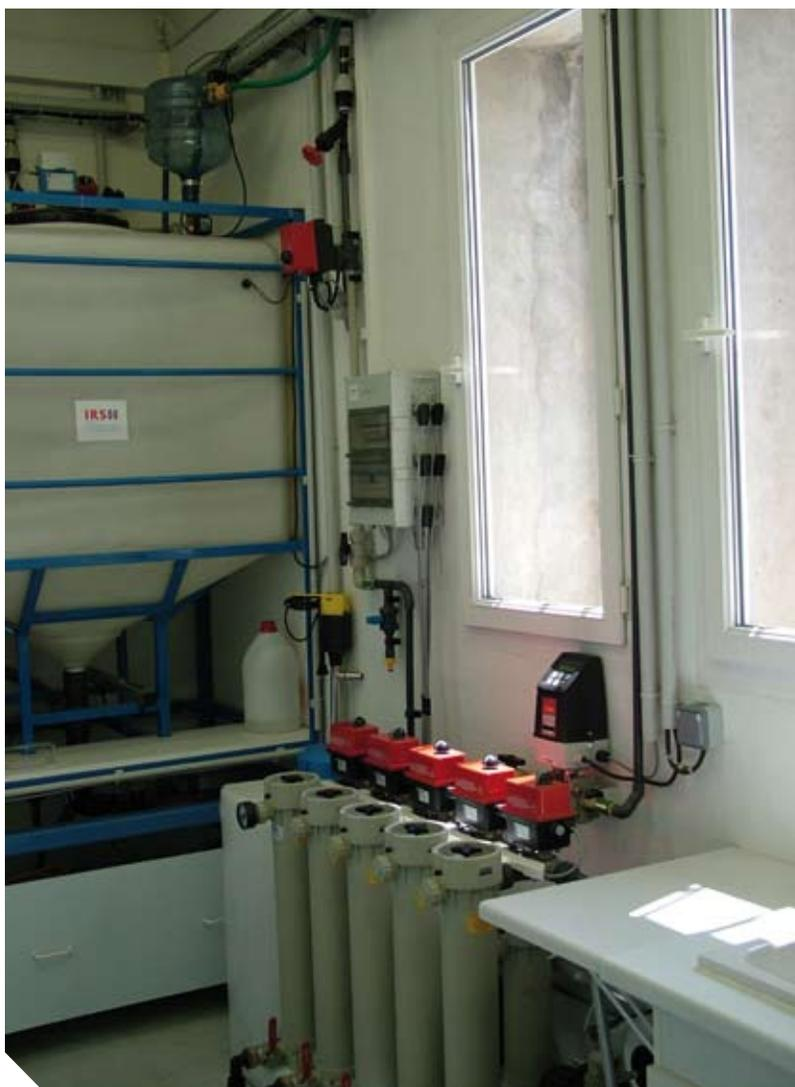
Station SORA : unité de filtration et de stockage d'eau filtrée pour l'étude des concentrations en radionucléides au cours de la montée de crue au niveau d'Arles (© O. Masson, IRSN)
