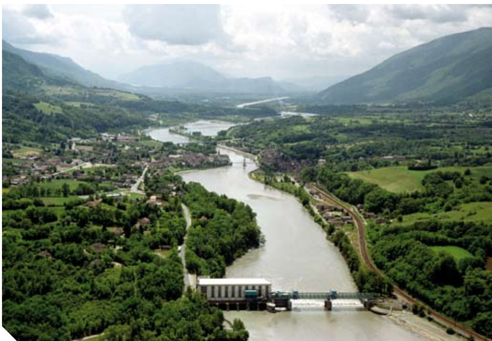
Le barrage de Seyssel, vue vers le sud (© Photothèque CNR).
