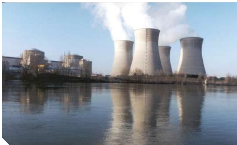
Centrale nucléaire du Bugey (© EDF)
