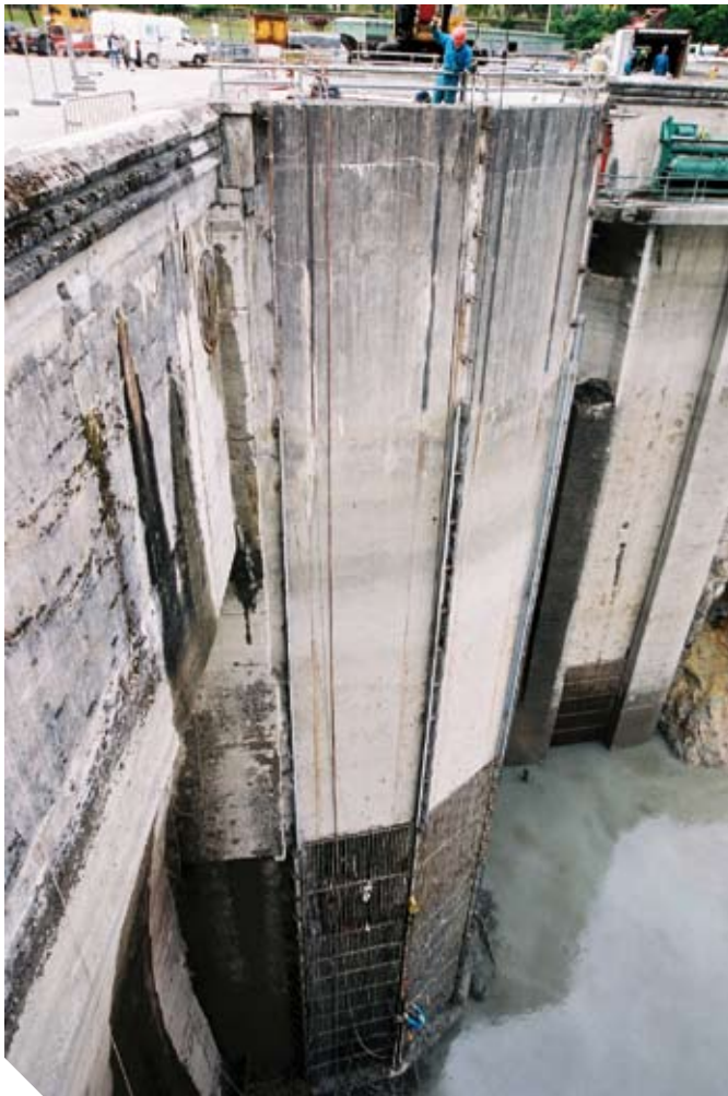
Entretien du barrage de Génissiat (© Photothèque CNR).
