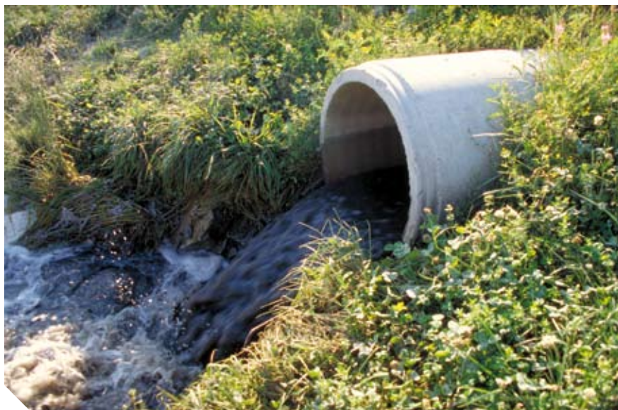
Déversoir d'orage : ouvrage rejetant directement et sans traitement, dans le milieu naturel, par temps de pluie, une partie des effluents des réseaux d'assainissement unitaires lorsque le débit amont dépasse une certaine valeur (© Le Grand Lyon/J. Léone)
