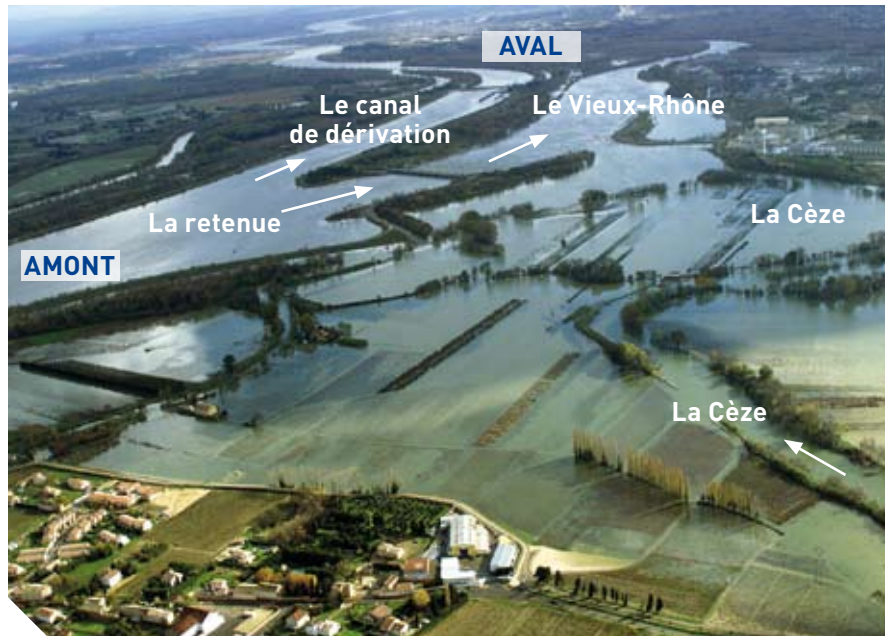
Crue de novembre 2002. La plaine de Codolet protégée des inondations directes par la digue de rive droite de la retenue de Caderousse est inondée par la Cèze ou par refoulement de la crue du Rhône (© Photothèque CNR).
