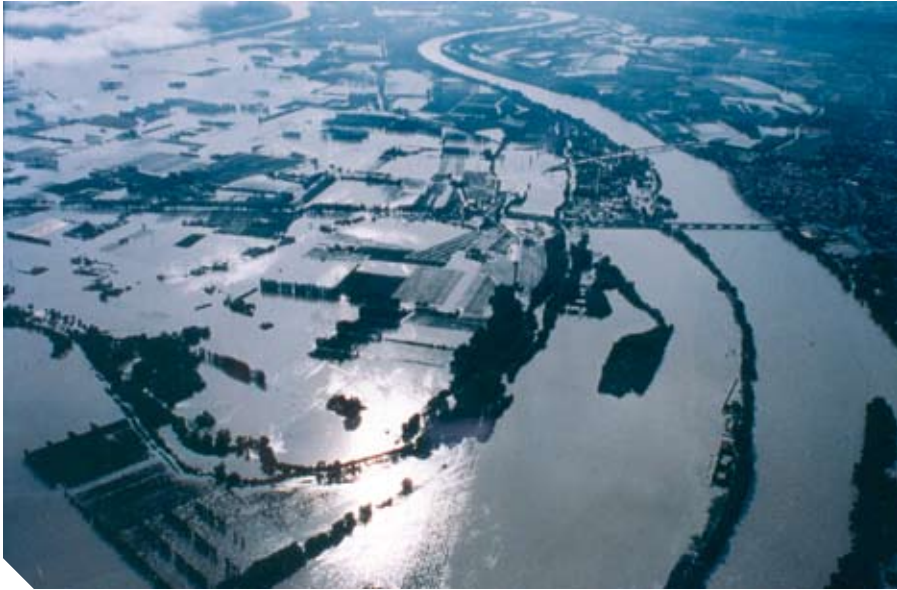
Plaine de Donzère inondée lors de la crue de 2003 (© Photothèque CNR).
