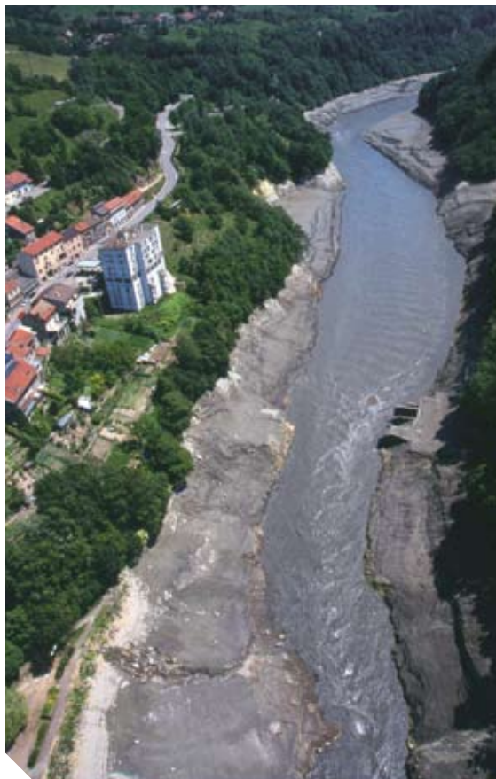
Chasse de la retenue de Génissiat sur le site de Bellegarde (© Photothèque CNR).
