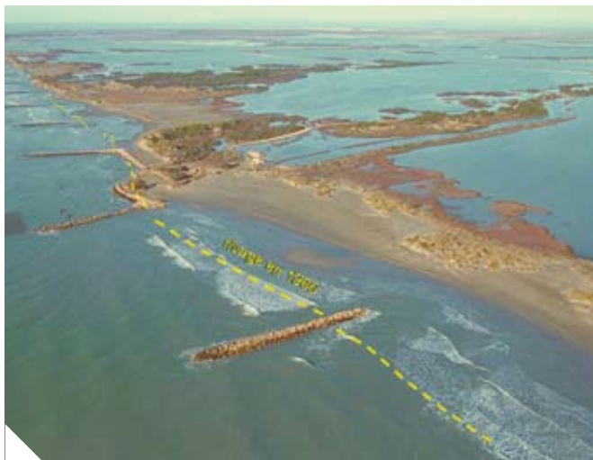
En Petite Camargue, les épis protégeant la plage sont «déconnectés» 8 à 10 ans après leur construction par le recul persistant de la côte (© Service Maritime et de Navigation du Languedoc Roussillon - SMNLR).
