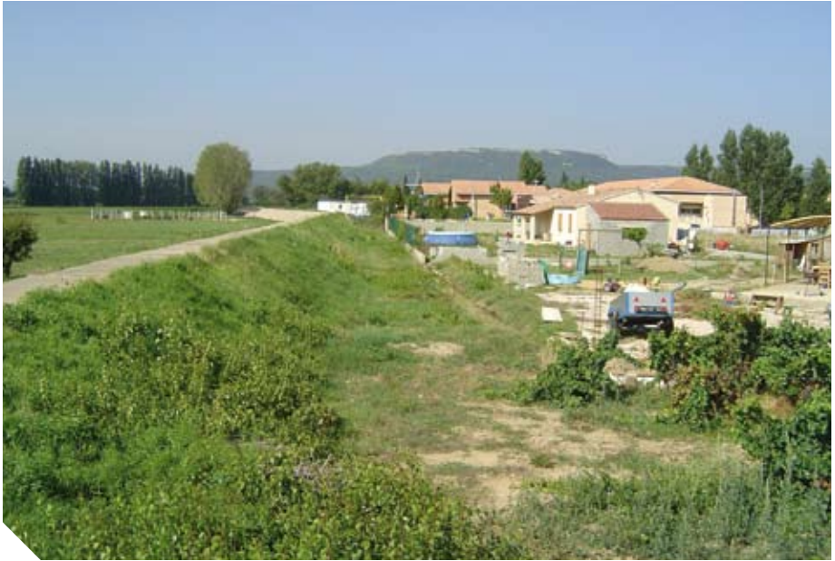
Digue de Codolet (Vaucluse), au Sud du village (© DIREN Rhône-Alpes).
