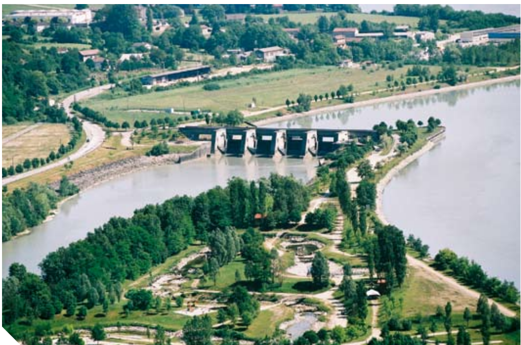
Le barrage de Sault-Brénaz et la rivière artificielle au premier plan (© Photothèque CNR).
