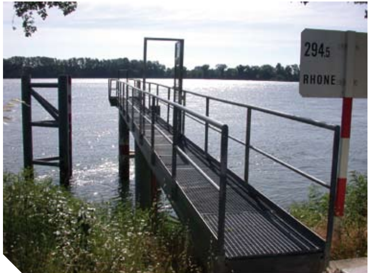
Le Grand Rhône et la station de mesure de salinité au PK 294.5 au seuil de Terrin (© Photothèque CNR).
