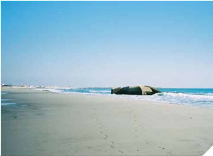
Aux Saintes-Maries de la Mer, le blockhaus allemand, construit à l'origine en haut de la plage et actuellement immergé, permet d'évaluer le recul (© M. Provansal).
