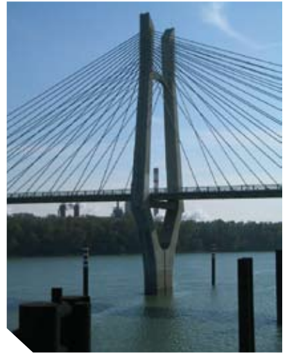
Le pont à haubans sur le Rhône entre Tarascon et Beaucaire. D'une longueur de 407,50 m, ce pont relie Tarascon à Beaucaire depuis 2000 (© E. Delahaye).
