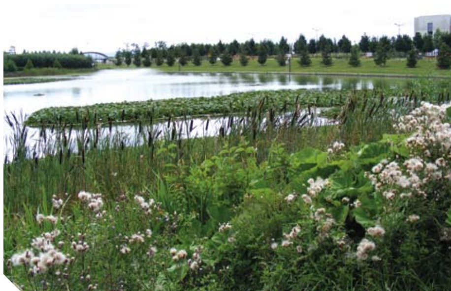
Aménagement paysager d'un bassin de rétention d'eaux pluviales, Porte des Alpes - 69 (© GRAIE)
