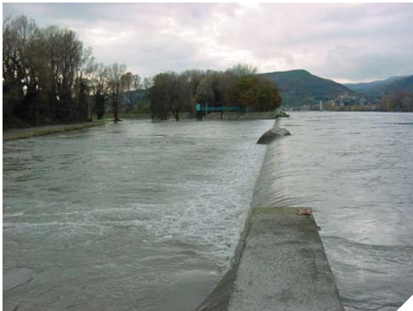
Déversoir de Printergarde lors de la crue de novembre 2002 (© Photothèque CNR).
