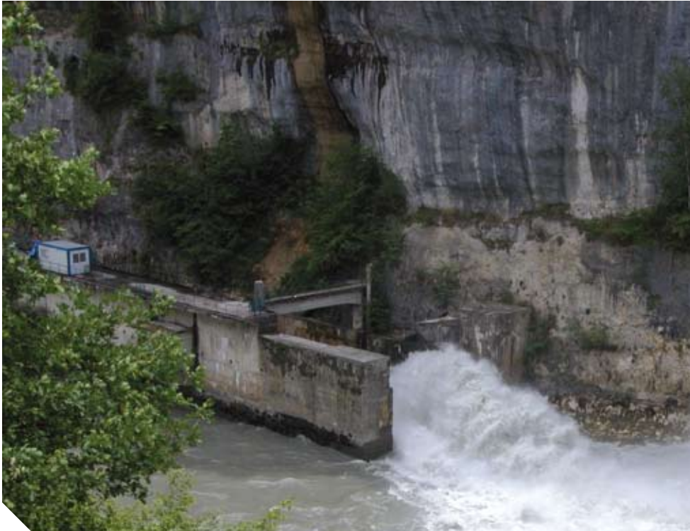
Évacuateur en fonctionnement lors d'une chasse (usine de Génissiat) (© Photothèque CNR).
