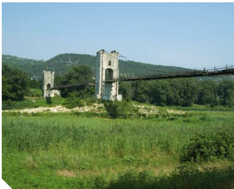
Le pont de Rochemaure. Le premier pont, construit en 1842, fut détruit par la crue de 1856. Le pont suspendu actuel remonte à 1858 ; ses piles construites en style château-fort s'harmonisent avec les ruines du château médiéval. Partiellement reconstruit après les bombardements aériens d'août 1944, ce pont n'est plus en service (© J.-P. Bravard).
