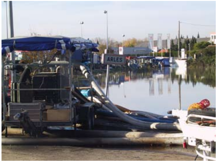
Pompage route de Fontvieille le 13 décembre 2003 (© E. Delahaye).
