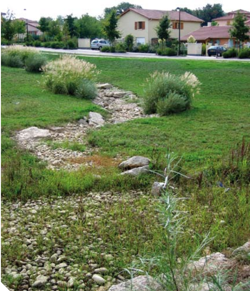
Noue ou fossé d'infiltration intégré aux espaces verts d'une zone pavillonnaire à l'Isle d'Abeau – 38 (© GRAIE)
