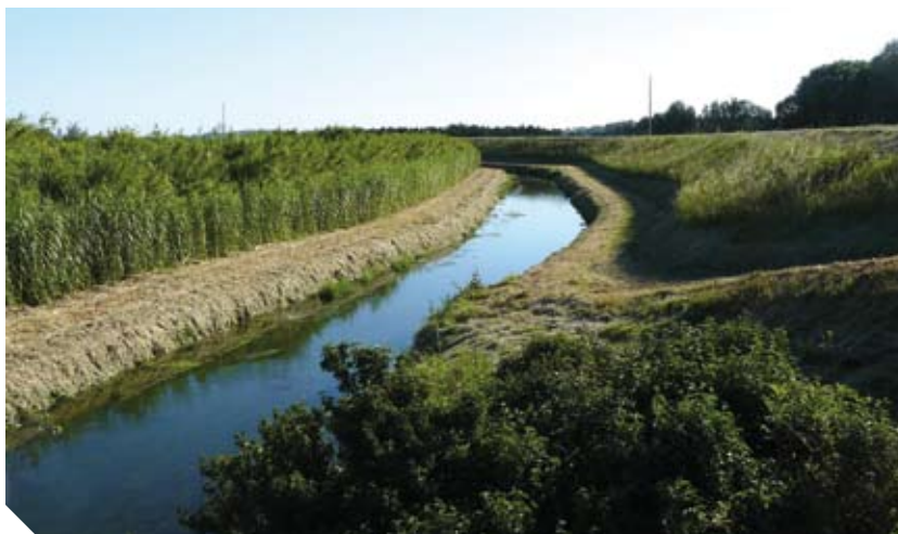
Canal de drainage en arrière d'une digue de protection dans le delta du Rhône (© P. Gaydou).
