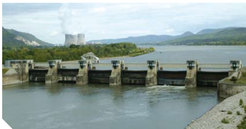
Barrage de Rochemaure et centrale nucléaire de Cruas (© Photothèque CNR).
