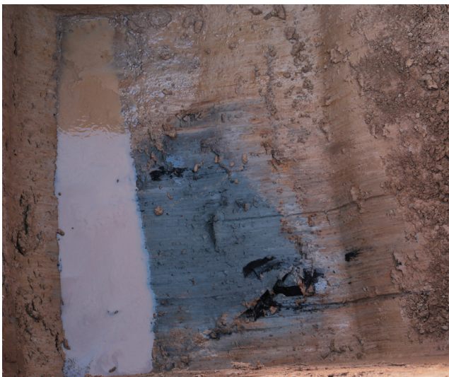
Fig.181 Niveau d'apparition du cuvelage en chêne du puits [3023] (cliché E. Hamon)
