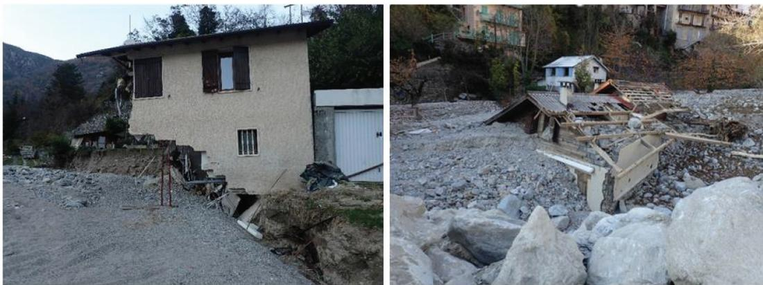
**Figure 6.** Exemple d'état de bâtis levé pendant le terrain post évènement : (gauche) St Dalmas de Tende, dommage important par affouillement d'intensité forte, y compris localement au niveau des fondations (source : ONF-RTM) ; (droite) St Martin Vésubie, dommages importants par engrèvement d'intensité forte sans affouillement des fondations (source : ONF-RTM).
