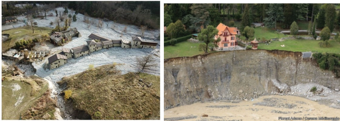
Figure 1. Photos de terrain post événement : (gauche) Dépôt sur le cône de déjection du torrent de la Morte avec bâtis engravés près de Viévol en Haute-Roya (source : V. Kouliniski, ETRM) ; (droite) Erosion de berge menaçant un bâti à St-Martin-Vésubie (source : F. Adamo, Cerema).
