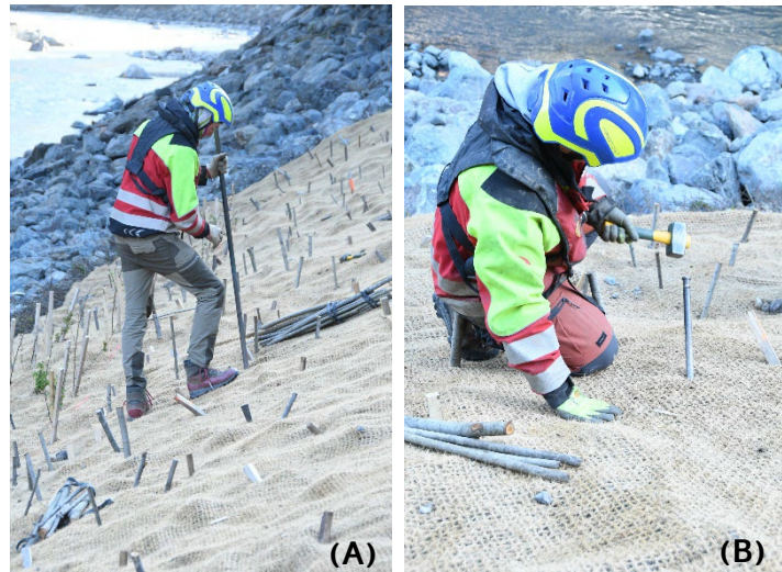
Figure IV-9: Création du pré-trou à l'aide (A) d'une barre en métal et, (B) d'une pointe en métal et d'un maillet © Luce Martin
