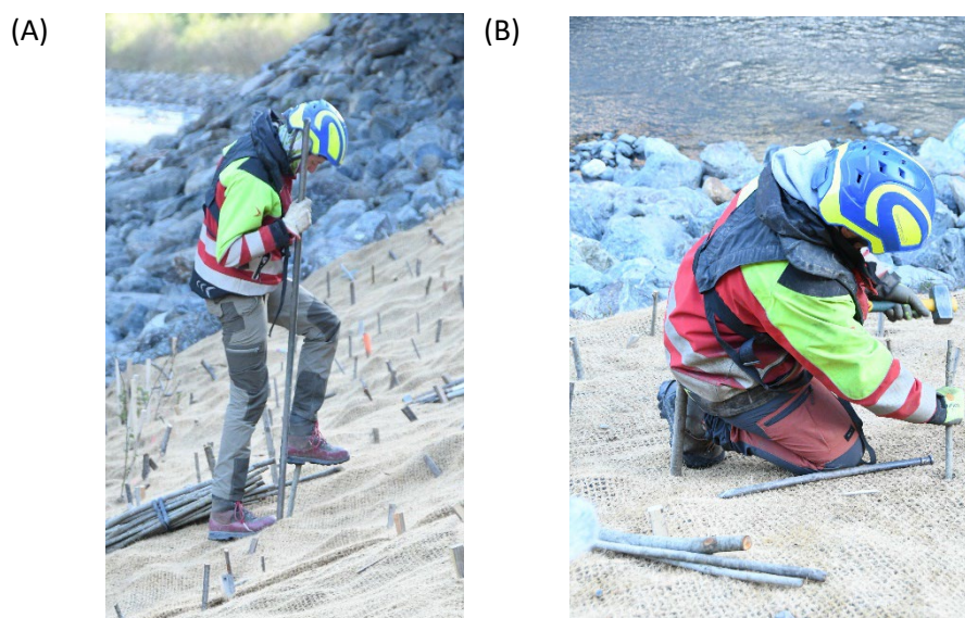
Figure IV-10: Mise en terre des boutures à l'aide (A) du pied et, (B) d'un maillet © Luce Martin
