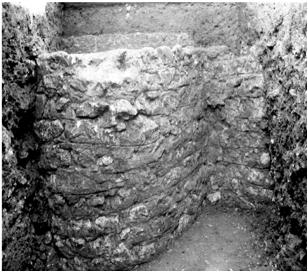
Fig. 23 : Vue du parement externe du mur 5.
