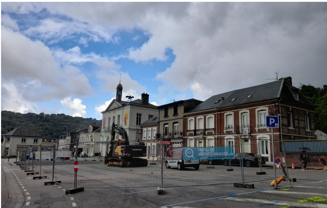
Fig. 32 : Vue de la place Félix-Faure à la fin de la préparation du chantier.
