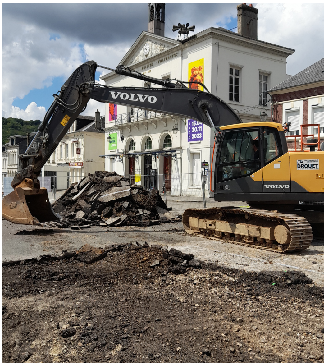
Fig. 33 : Vue vers le nord-ouest du retrait de l'enrobé en cours. © cliché Jonas Parétias / Caux Seine agglo.
