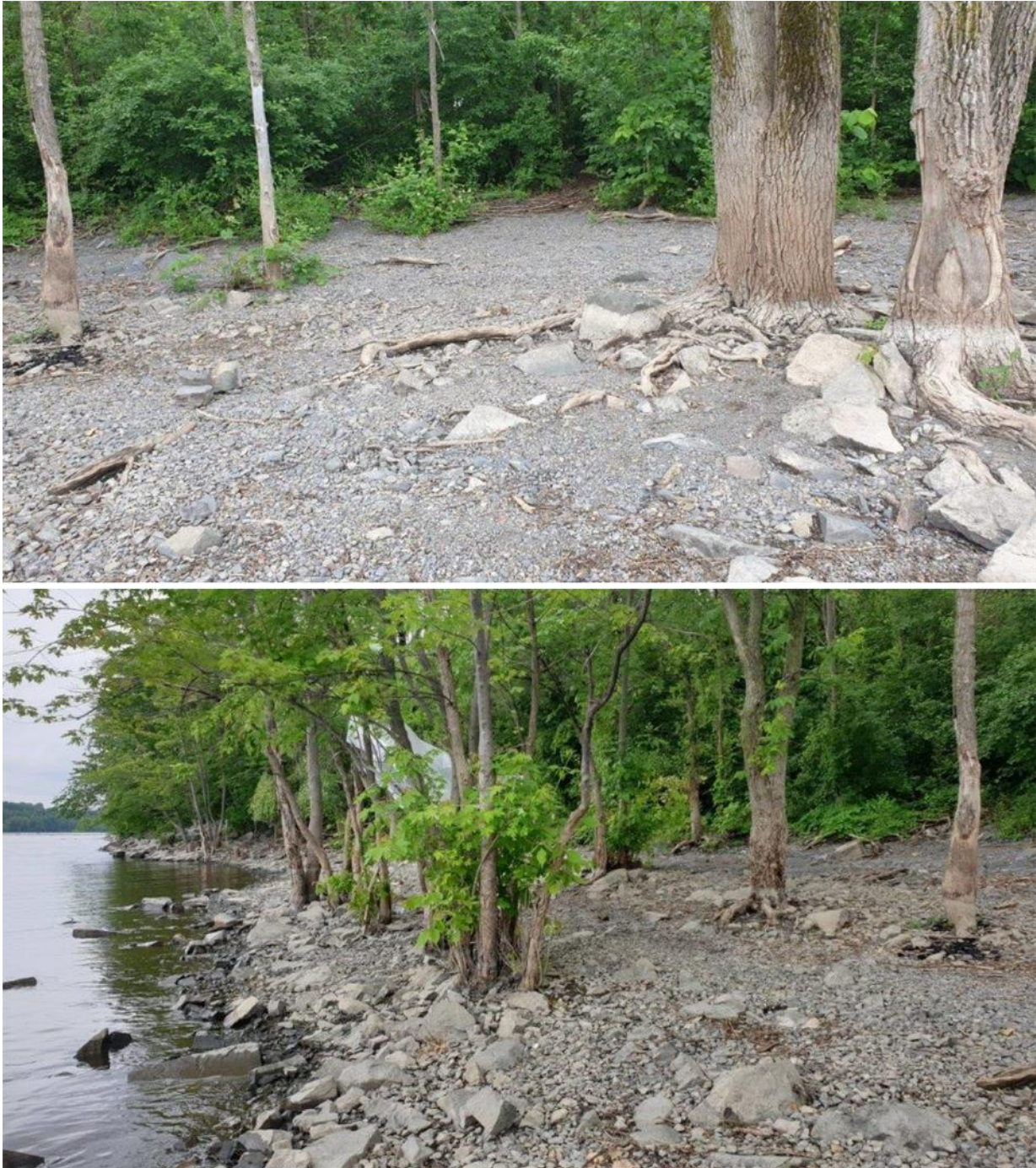
Figure 23 Tronçon 1050 montrant un sol dénudé et compacté où des efforts de revégétalisation sont proposés.
