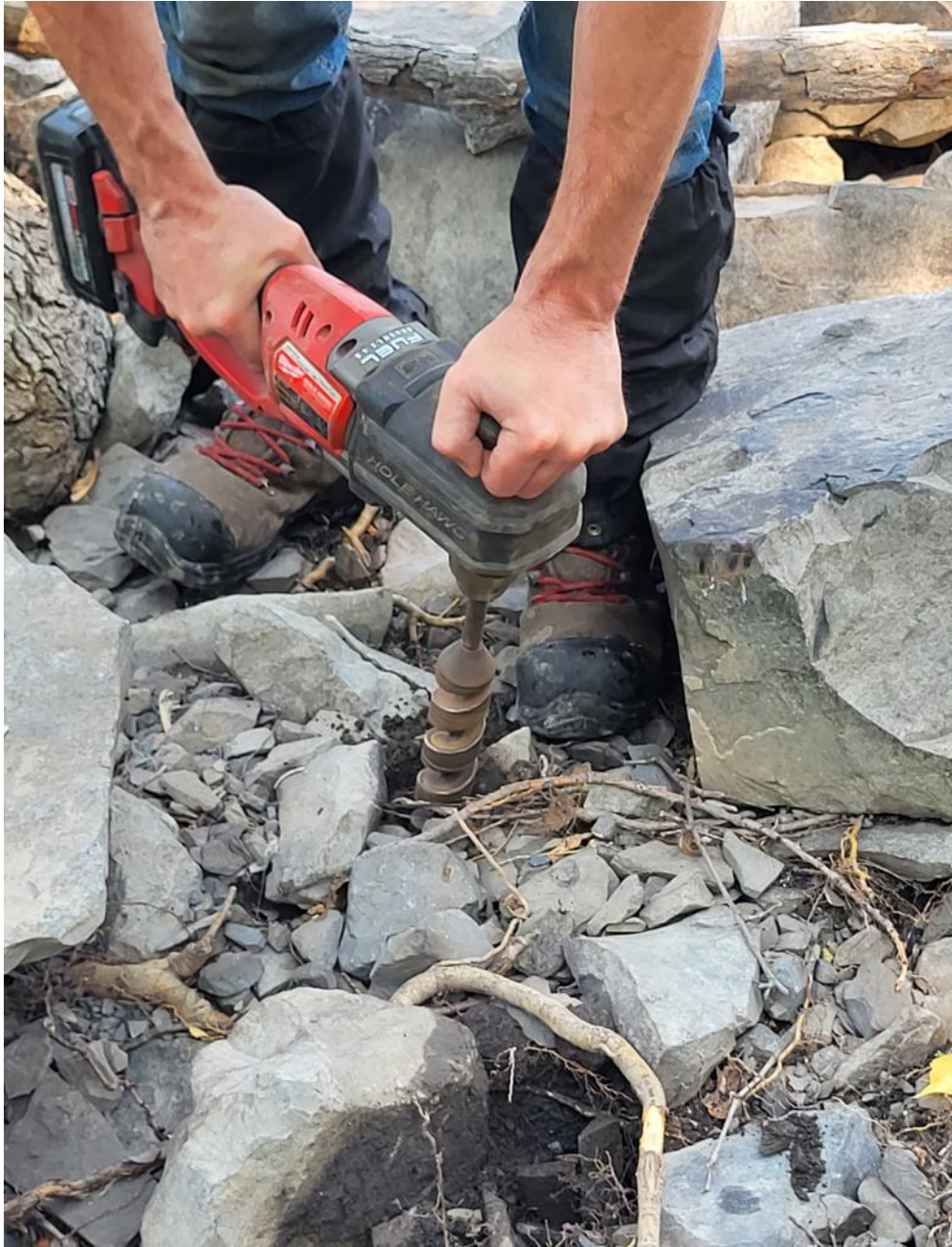
Figure 14 Utilisation d'une foreuse pour vérifier la possibilité de mettre en place des boutures en pied de berge au parc Promenade-Bellerive. Malgré la présence de grosses roches, le sol rend l'installation de boutures possible, selon ce test à la foreuse lors de la campagne terrain de juin 2023.
