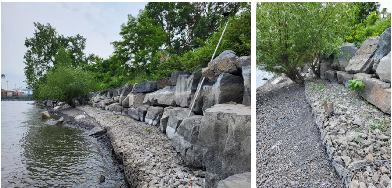
Figure 13 Tronçon 1024 du parc Promenade-Bellerive stabilisé par des gabions en bas de talus et des gros blocs de roches alignés au-dessus.
