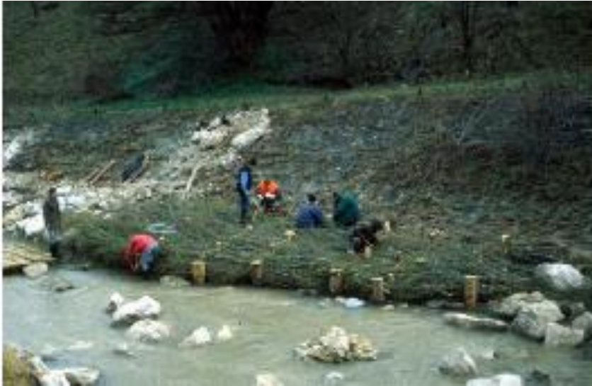
Photographie d'une construction de grilles de branches, région du Tyrol, Autriche. Tiré de Florineth (2007).
