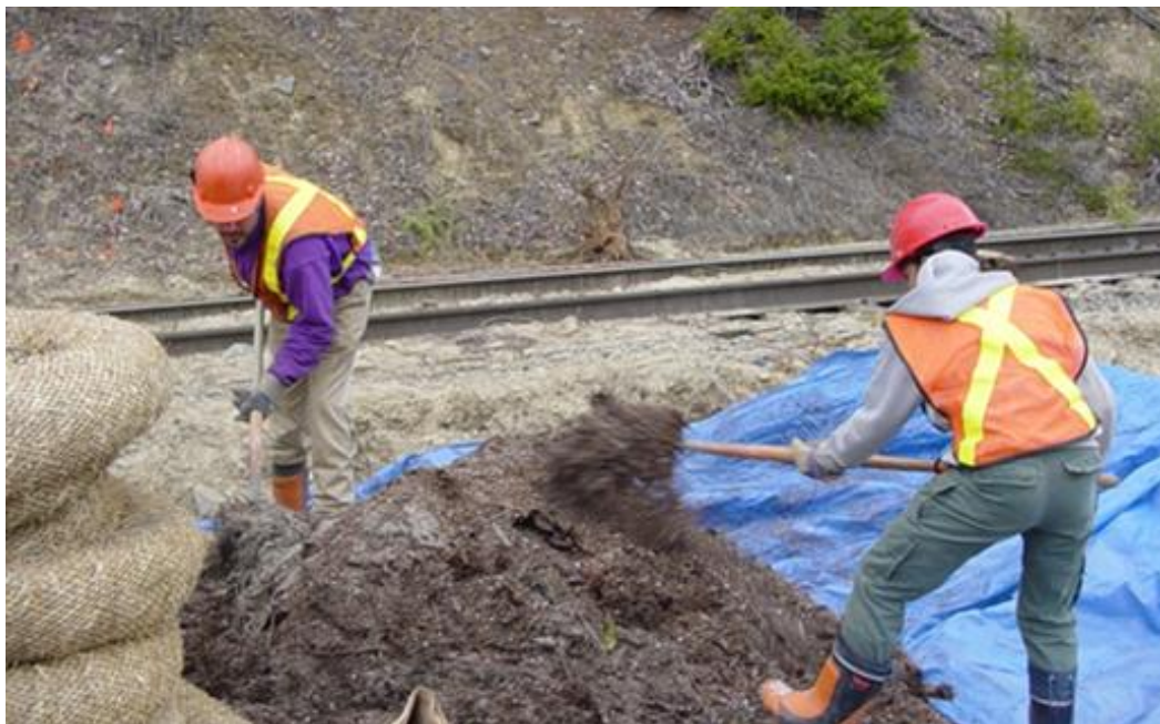
Mélange des différentes composantes de l'amendement sur le chantier © Terra Erosion Control Ltd.
