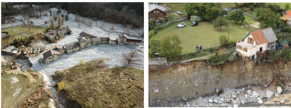
Figure 1 : Photos de terrain post évènement : (gauche) Vue drone, Vieville (source V. Koulinski ETRM) ; (droite) érosion de berge menaçant un bâti (source : F. Adamo Cerema)
