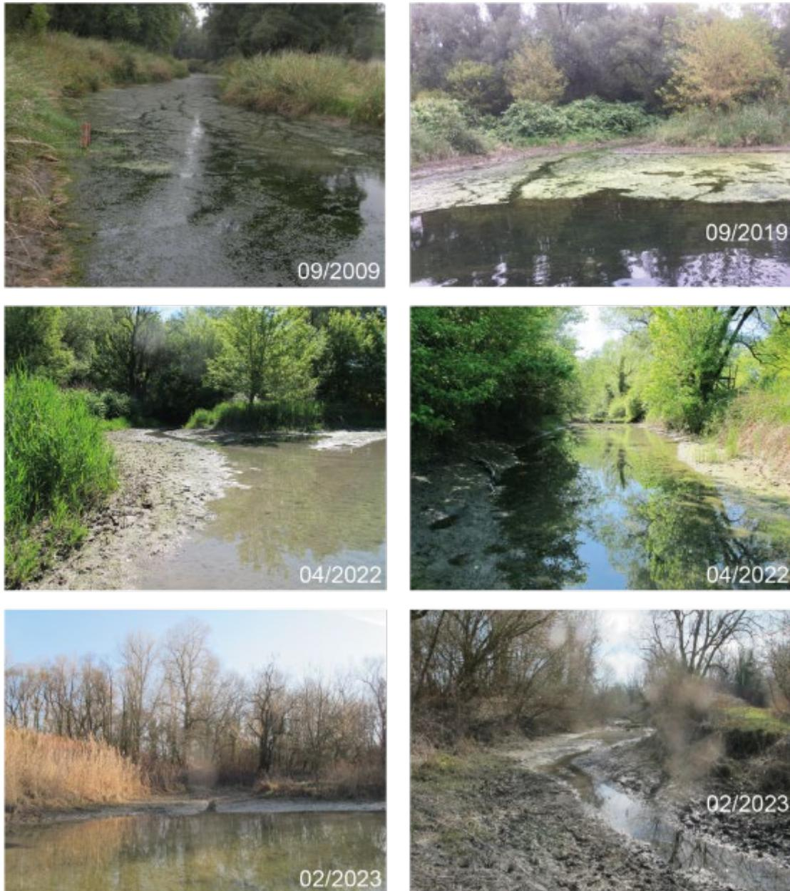
**Figure 6.3-11** - Ensemble de photographies de la lône des Molottes, prises quelques années après sa réhabilitation (09/2009) et plus récemment, illustrant l'accumulation de sédiments fins au niveau de la connexion aval.
