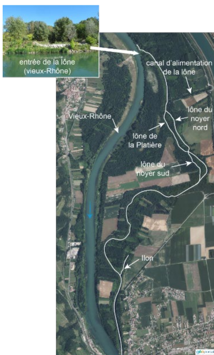
Figure 6.3-15 – Vue aérienne du secteur de l'île de la Platière et tracés des lônes du secteur. La digue longitudinale en rive gauche du Vieux Rhône a été abaissée afin de permettre une alimentation de la lône lorsque le débit dans le Vieux Rhône atteint 600 \text{ m}^3 \cdot \text{s}^{-1} .
