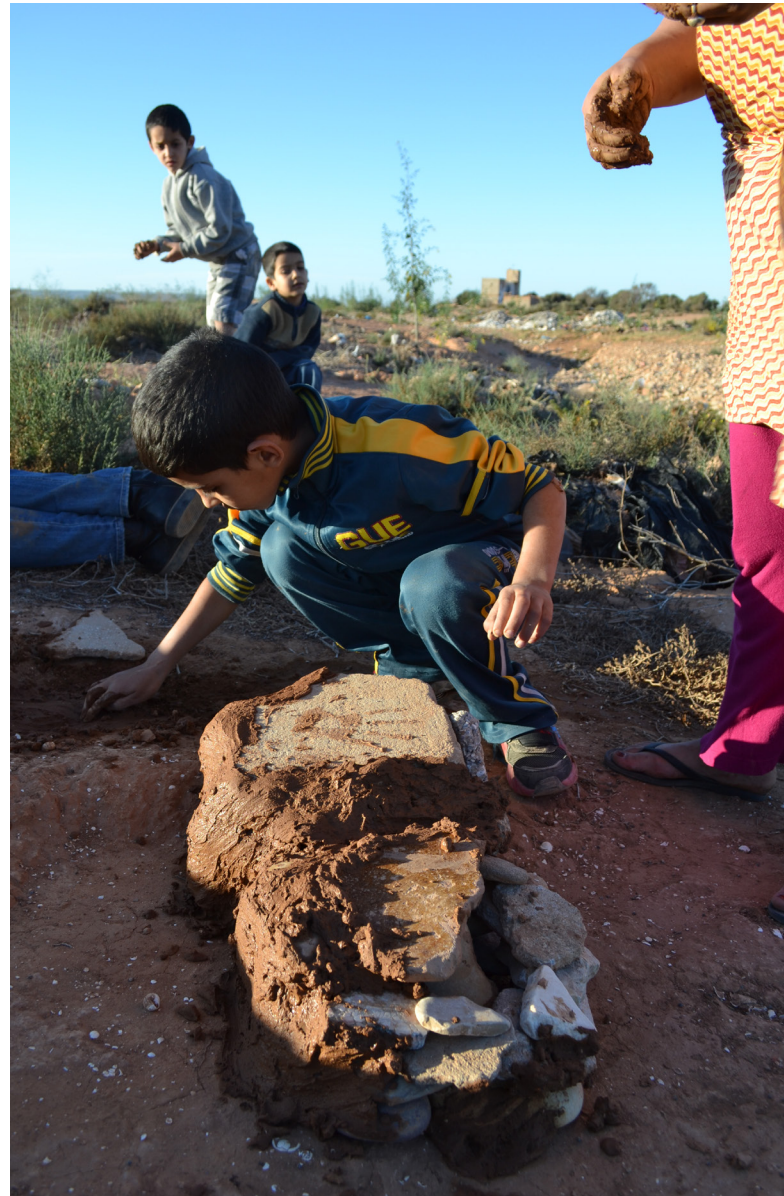
Fig. 3. Construction de deux taghouni l'un à côté de l'autre (Douar Ouaraben, région de Tiznit, 2016). © Photo A. Fassoulas.
