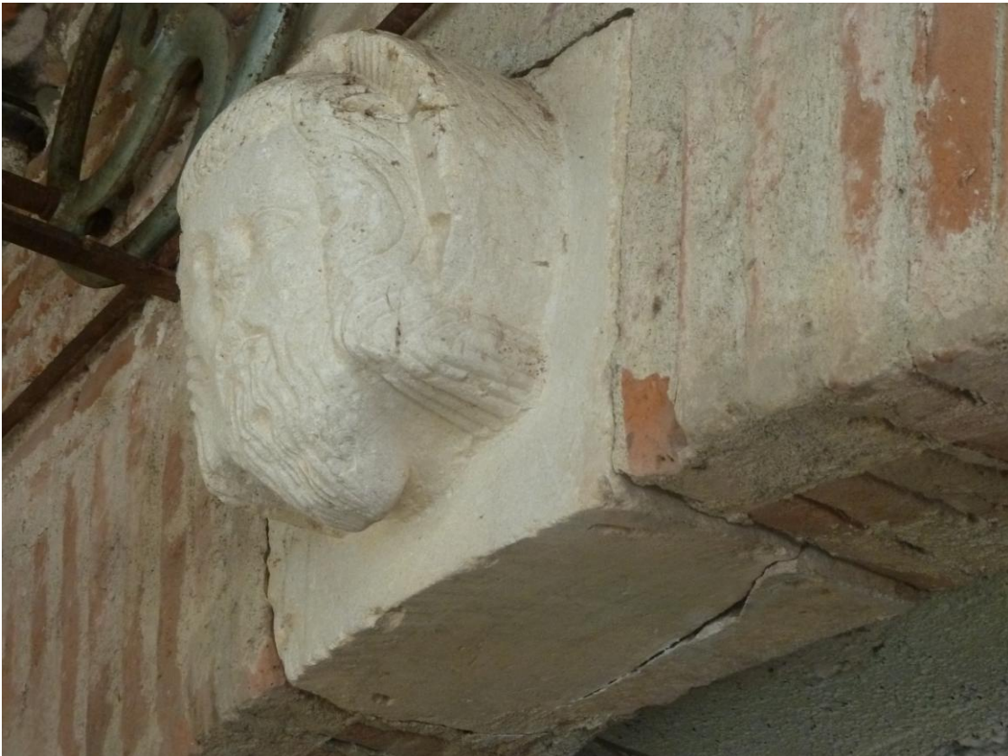
Fig. 6 : Carbonne, Moulin de Ferrery, le voussoir au Christ installé à l'entrée du moulin (Cliché C. Balagna).
