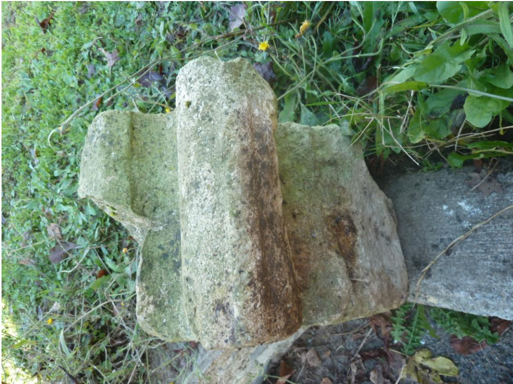
Fig. 1 : Carbonne, Moulin de Ferrery, le voussoir d'une baie ? (Cliché C. Balagna).
