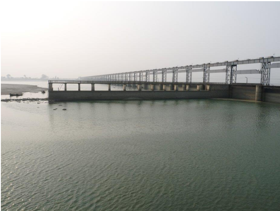
Photo 4 : Le barrage de la Koshi, localisé au Népal à la frontière avec l'Inde, sert à réguler le flux de la rivière pour éviter les inondations et à dévier l'eau pour l'irrigation de terres situées essentiellement en Inde. Le barrage est d'ailleurs géré par les ingénieurs indiens. (Photo O. Aubriot 2010)
