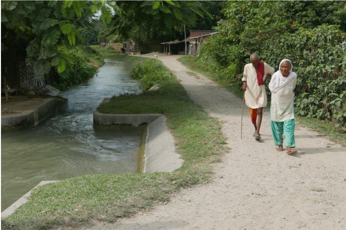
Photo 6 : Les branches de canaux étatiques circulent au milieu de villages, ici dans la plaine du Népal, dans le district de Sunsari (Photo O. Aubriot, nov. 2017)
