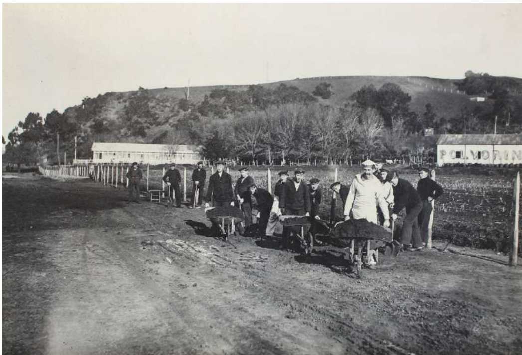
60 Bei Wegebau [Construcción de un camino]
