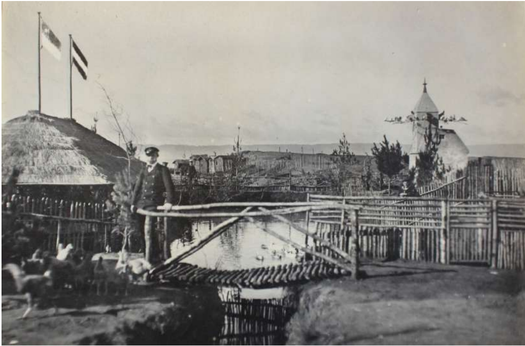
33 Anlagen der Deckoffiziere [Instalaciones de los oficiales de cubierta].
