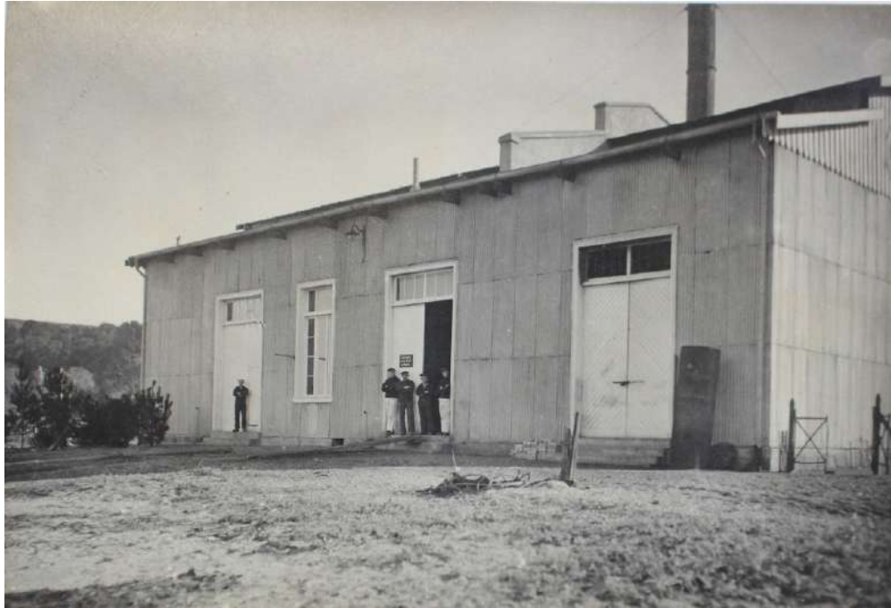
63 Elektrizitätswerke [Planta eléctrica]
