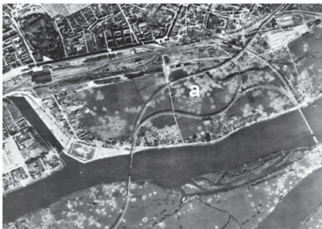
Photo 4 : vue aérienne du bombardement du 28 mai 1944 ayant notamment affecté la zone de la gare de Nantes et une partie de l'île Beaulieu (source : www.archives.nantes.fr ). (a) Localisation de la Petite Amazonie.
