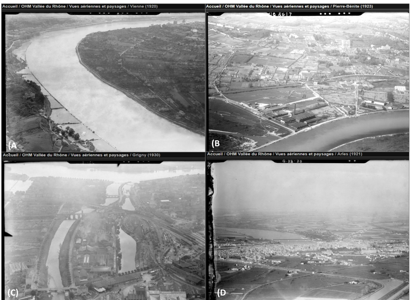
Figure 22 : Photographies aériennes obliques montrant des aménagements du Rhône toujours en service ou disparus : (B) Vue du Rhône en amont de Vienne le 20/07/1920. Les casiers Girardon sont visibles en rive gauche ; (A) Vue du Rhône et de l'usine de La Volta lyonnaise à Pierre-Bénite (aujourd'hui usine Arkema) le 20/04/1923. L'usine de La Volta lyonnaise, installée en 1902 est la première usine française d'acide sulfurique anhydre pour répondre aux besoins de l'industrie des colorants. A gauche de l'usine, l'entrée de la lône de Pierre-Bénite aujourd'hui disparue ; (C) Vue de la confluence Rhône-Gier à Givors le 27/07/1930. Le canal de Givors et le bassin du canal furent comblés dans les années 1960 ; (D) Vue du Rhône à Arles le 09/03/1921. Premier ouvrage fixe sur le Grand Rhône, le "pont aux Lions" construit en 1866 marque l'arrivée du chemin de fer à Arles. Il est détruit en 1944. Seules subsistent aujourd'hui les statues de lions sur les culées. Au premier plan, le canal de navigation d'Arles à Bouc construit de 1804 à 1834
