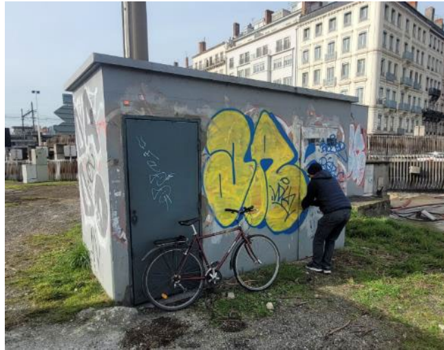
Figure 9 : Cabane de mesure du Grand Lyon au niveau de Perrache
