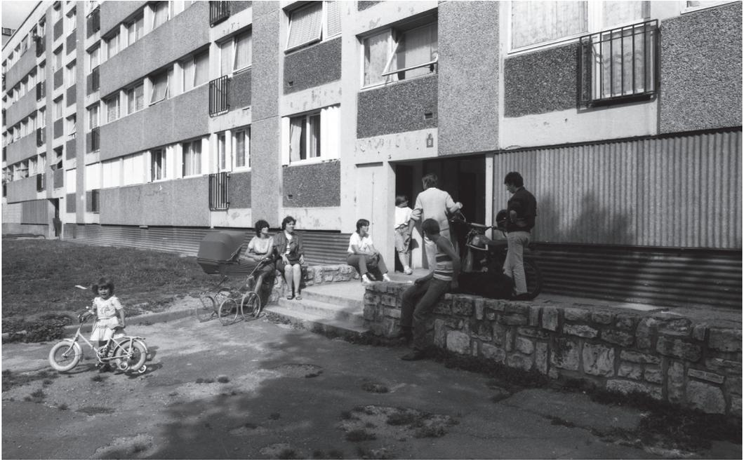
Fig. 3 - Photographie au pied d'un immeuble barre, années 1980. Les espaces à l'entrée des immeubles sont défraîchis par les usages quotidiens et les châssis des fenêtres sont défectueux, contrairement aux panneaux en façade.
