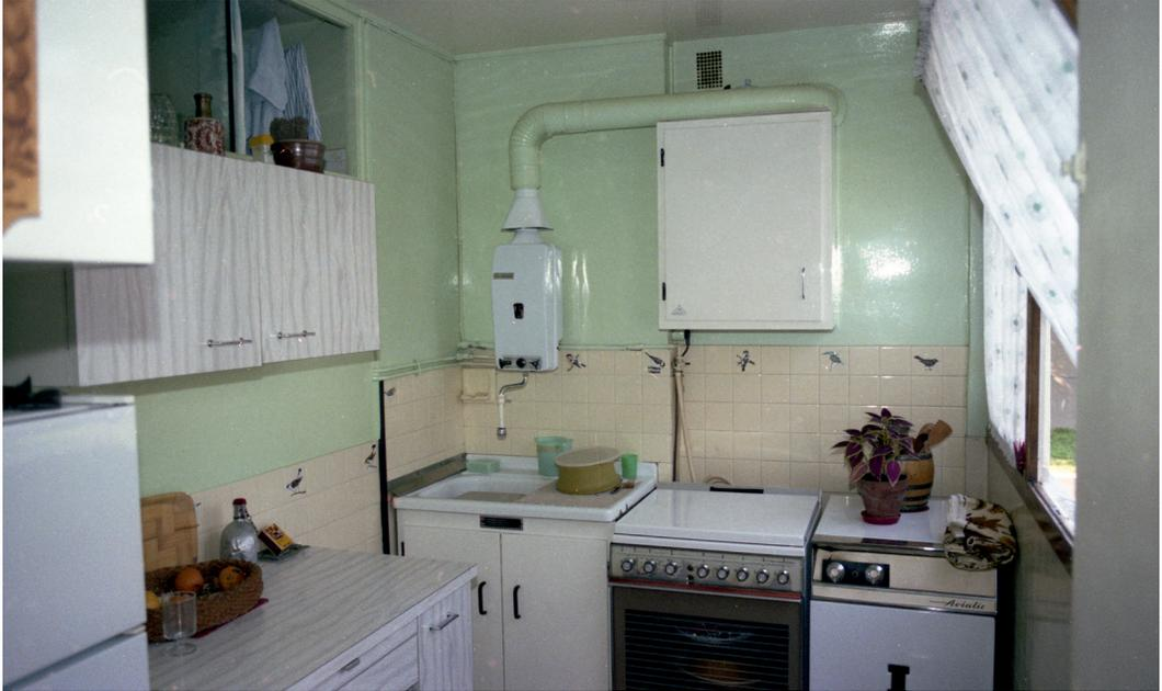
**Fig. 6** - Photographie couleur d'une cuisine d'un immeuble barre, années 1980. Les cuisines sont petites dans le programme du secteur industrialisé. À Aubervilliers, la baie horizontale (en haut à gauche) éclaire en second jour la salle de bains, permettant ainsi la ventilation naturelle des pièces humides.
