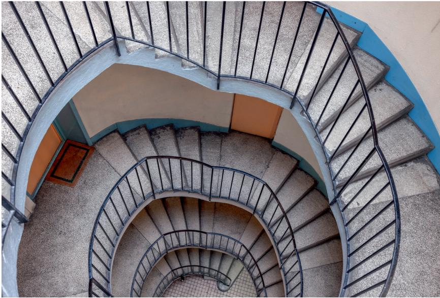
Fig. 4 - Cage d'escalier d'un immeuble barre, 2021. Les logements sont distribués par demi-niveau dans la cage d'escalier. Ce sont tous des trois-pièces de 52 m<sup>2</sup> avec une distribution identique à l'intérieur.
