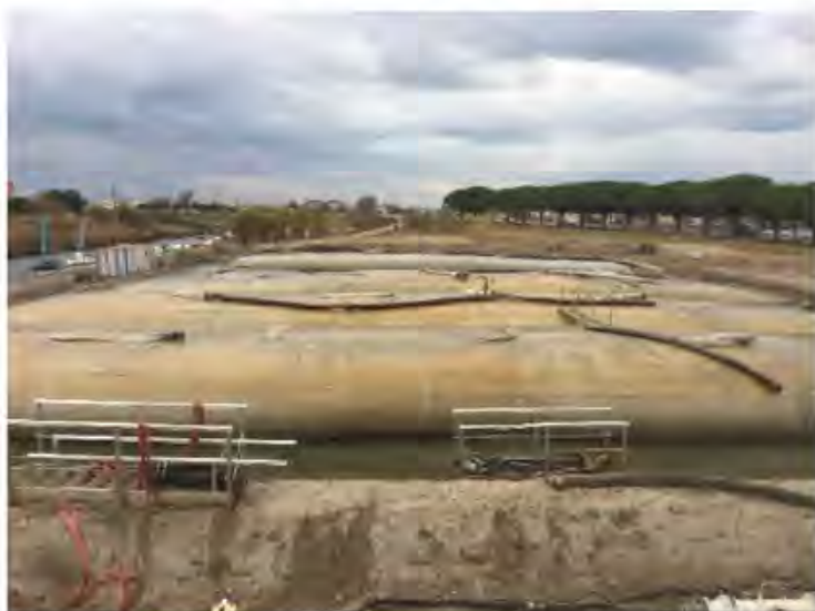
Géotubes de déshydratation des sédiments - Pérols (crédit I. Techer 2021)
