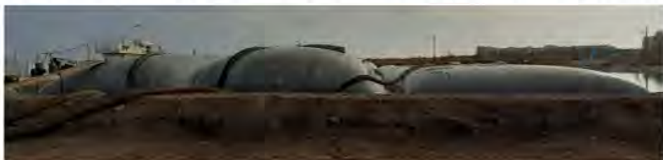
Déshydratation en géotubes - Pérols (crédit F. Sordes 2020)
