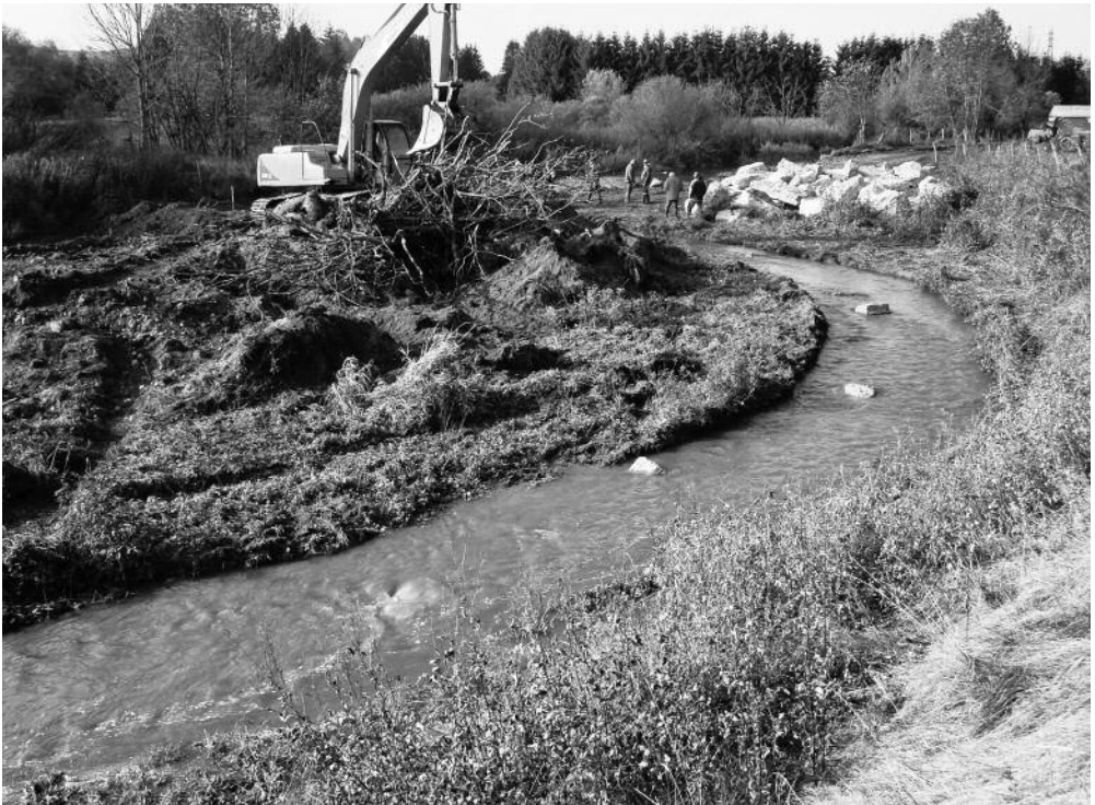
PHOTO IV.— Travaux de reméandrement de la rivière Drugeon (cliché Jean-Noël RESCH).
