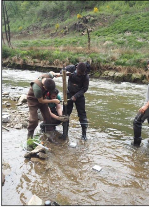
Figure C2: installation des sondes dans les sédiments de la rivière. La mise en place des sondes dans des petits tubes PVC crépinés adaptés à chaque type de sonde. Les tubes PVC sont enterrés en effectuant des pré-trous à l'aide de pieux métalliques avec un système de pilon. Ce protocole d'installation nécessite trois personnes pour être efficace sur la Sélune dont le lit est résistant.
