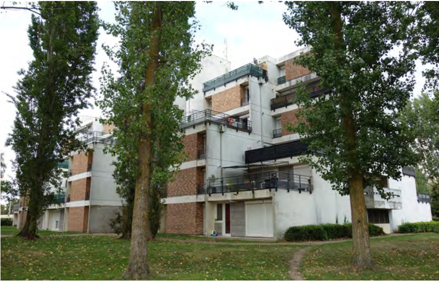
Compiègne : Résidence « La Peupleraie », Picardie Habitat (réhabilitation annoncée)
