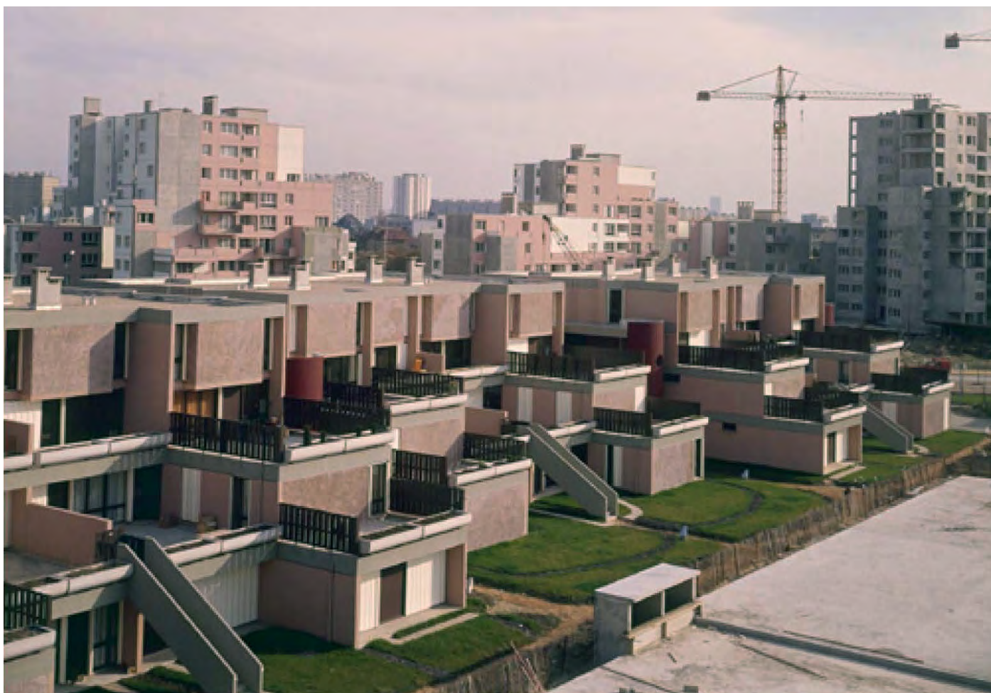
Vue d'ensemble de la portion sud, à la fin du chantier (au fond, l'ensemble du Pont de Bois) [DR Joly & Cardot, Centre Pompidou / Bib Kandinsky, vers 1976]
