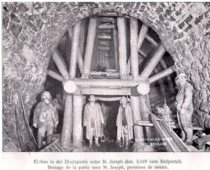
Fig. 17. Tunnel du Weissenstein (construction 1903-1908), étais lors de la construction, au km 3,449 à partir du portail sud, partie sous pression. La géologie et les venues d'eau ont causé beaucoup de problèmes aux constructeurs (Bibliothèque EPF Zurich, archives iconographiques / Photographe : Schenker-Wirz, E. / Hs_1002-0007-014 / CC BY-SA 4.0.).
