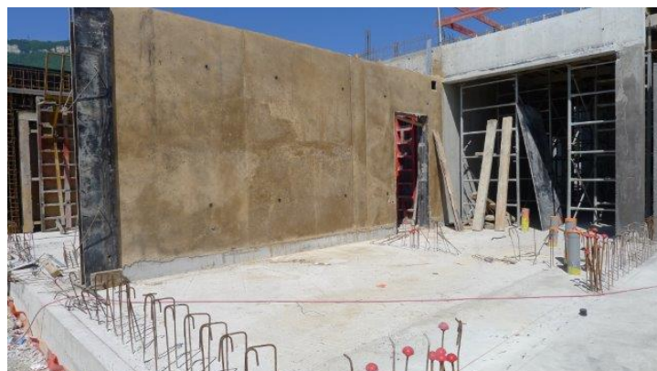
Fig. 09 & 10_ Voile de refend porteur en béton de terre coulée _ chantier CTE ouest à Fontaine (38)
