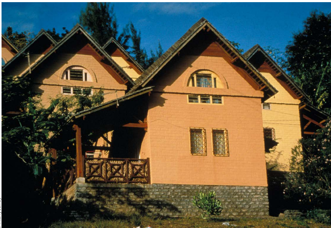
Habitats locatifs réalisés en blocs de terre comprimée (BTC), Mayotte, 1988.
