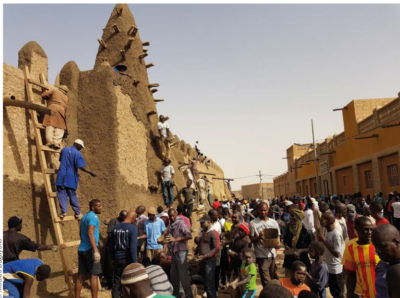
Maintenance traditionnelle de la mosquée Djingareyber à Tombouctou par la communauté locale, 2017.
