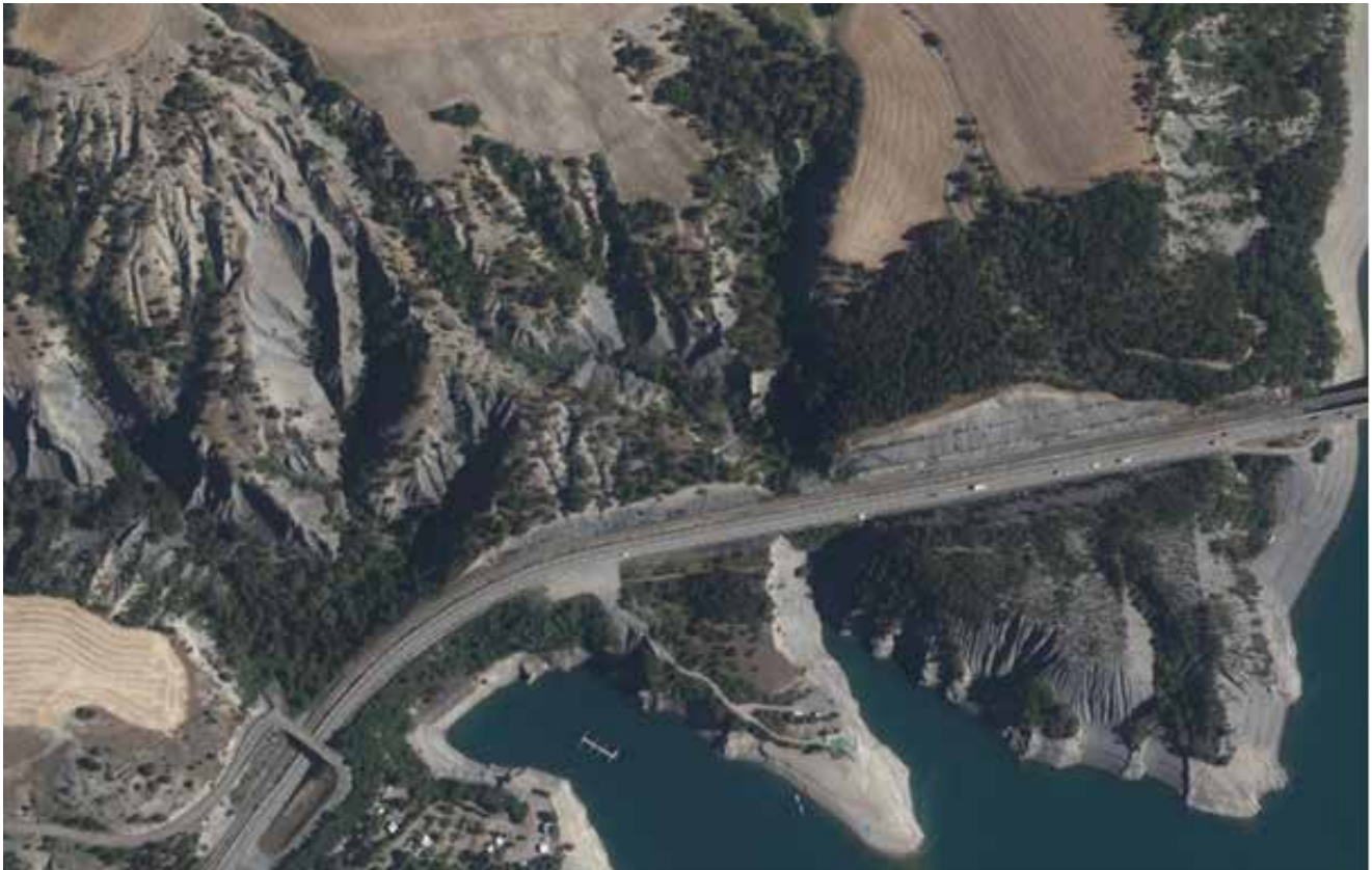
↑ Figure 1. Paysage marqué par le ravinement au bord du lac de Serre-Ponçon (source : Géoportail)
