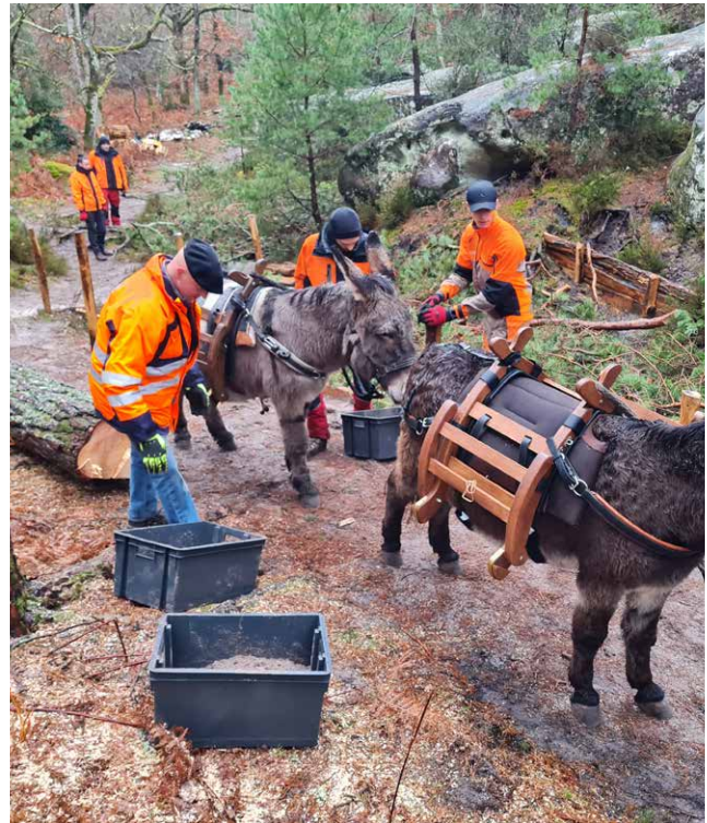
↑ Figure 10. Travail avec des ânes de portage pour acheminer les matériaux sur le chantier
