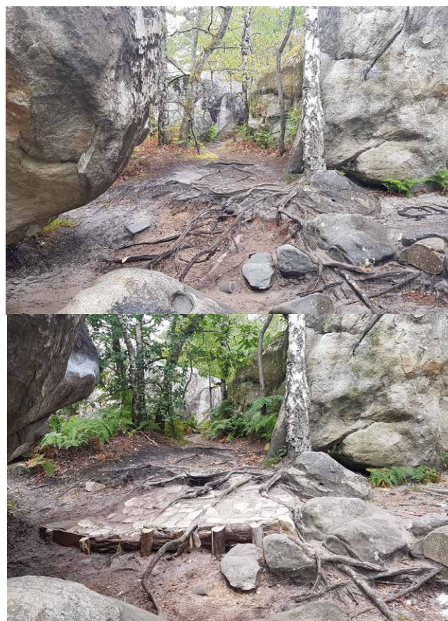
↑ Figure 6. Avant/après : Dallage créé en respectant les éléments présents (racines, blocs) au pied d'un rocher fréquenté par les grimpeurs
