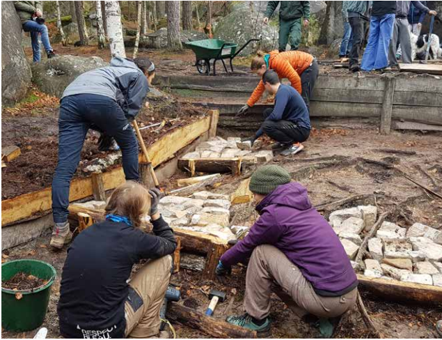
↑ Figure 7. Création d’emmarchements avec dallage lors d’un chantier participatif
