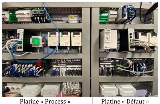
Figure 2 - Parties commande process et défaut TELMA Valenciennes
