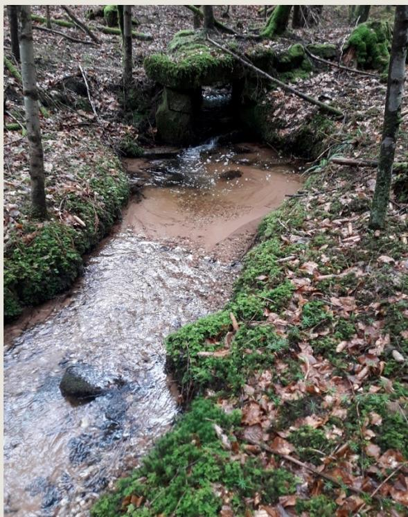
↑ **Figure 1.** Ensablement visible en sortie de buse, dans la fosse de dissipation d'énergie. Le substrat est complètement bouché par les sédiments fins
