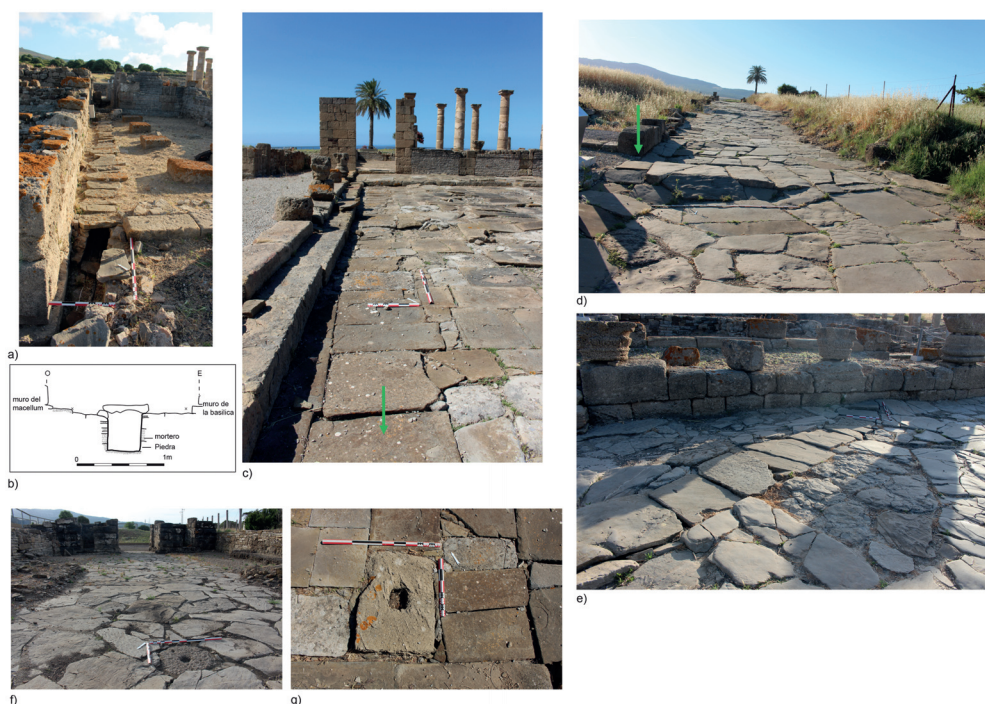
Fig. 8: a) Vista hacia el norte de la cloaca del ambitus occidental del forum en la que desemboca la cloaca del macellum (fotografía de L. Borau) b) Sección transversal de la cloaca (fotografía de L. Borau) c) Vista hacia el sur de la cloaca oriental del foro (fotografía de L. Borau) d) Vista hacia el este del colector que atraviesa el decumanus cerca de la puerta occidental (fotografía de L. Borau) e) Vista hacia el norte del colector que atraviesa el decumanus delante del macellum (fotografía de L. Borau).
