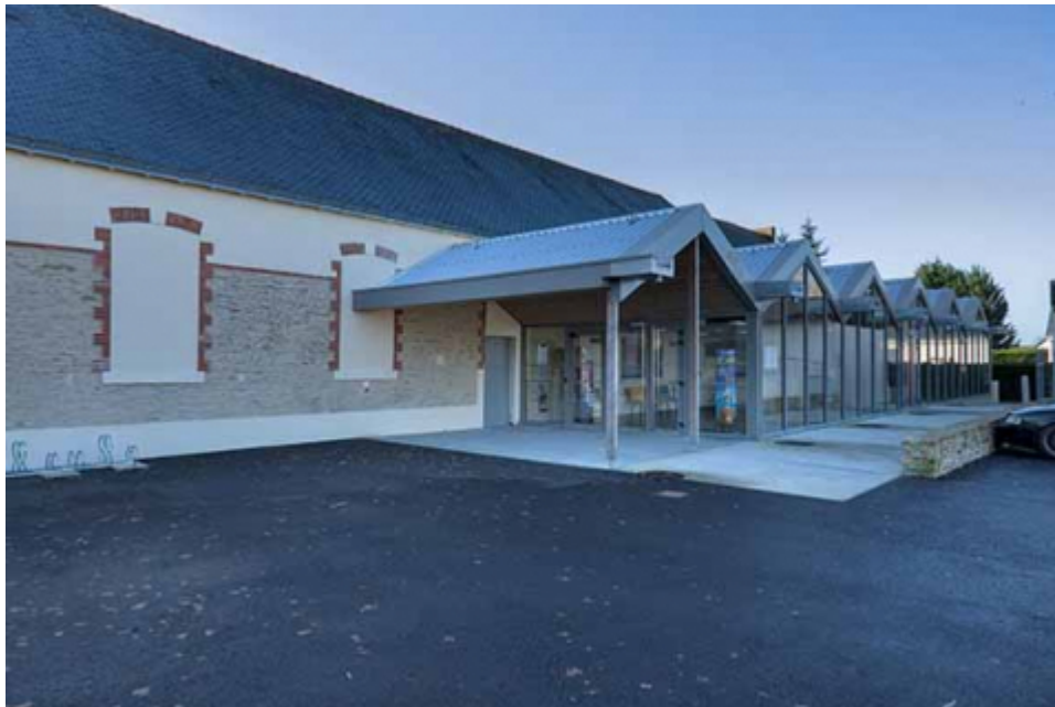
Figure 3 : Le cinéma de Héric, proche du centre-bourg, rénovation
