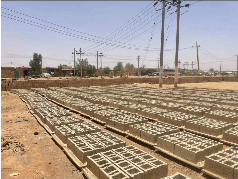
Illustration 4 - Usine de parpaings à Salha
