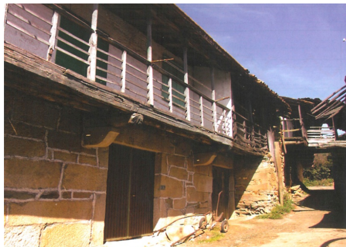
Figura 10: Vivienda en Castrelo do Val (Ledo Cabido, 2005).
