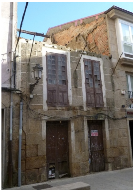
Figura 5: Vivienda de entramado con fachada de piedra ocultando su estructura.
