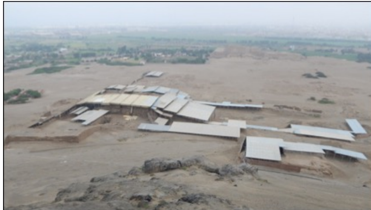
Figura 06: Huaca de la Luna, v. Moche. Cubiertas y drenes, protección de espacios y murales.
