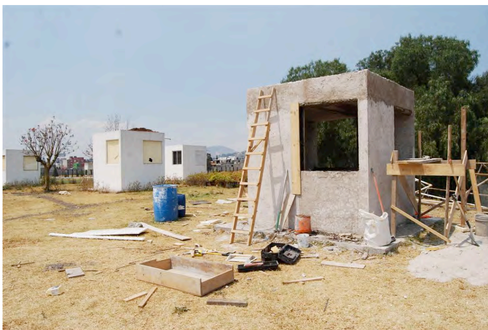
Figura 4. Módulo de TVC con muros de 15cm de espesor, Zacatenco, Ciudad de México. Foto: Luis Guerrero.
