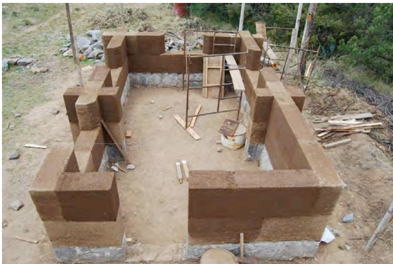
Figura 5. Primera hilada de los bloques de TVC para la casa de Tlaxco, Tlaxcala. Foto: Luis Guerrero.
