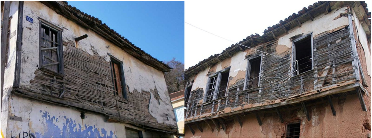
Fig.5 _ Examples of earthen filling techniques «τσατμάς» (tsatmas) and «Μπαγδατί» (Bagdati).
