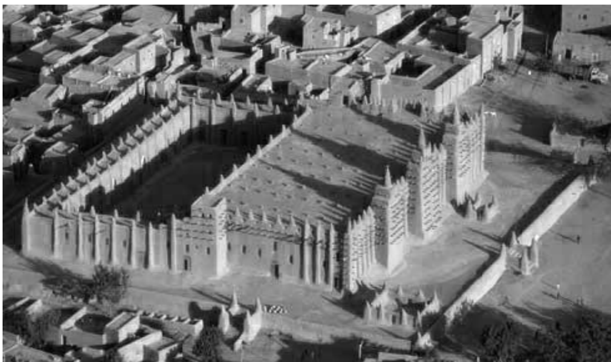
Fig.2 : Vue de la mosquée et environs
