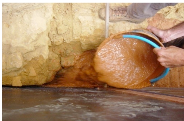
Fig.5 Unión de vacíos con barro reforzado
