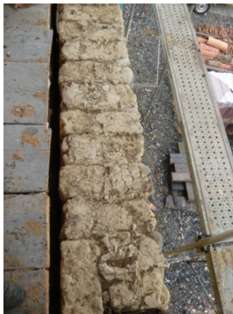
Fig.3 : Disposition des adobes et galets dans les murs en damier du Magnoac (© A. MARCOM)
