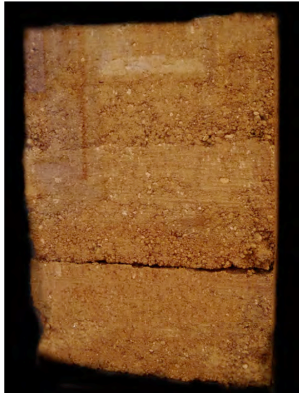
Fig. 8 : Couvent des Ursulines : détail du pisé (© Ricaud).
