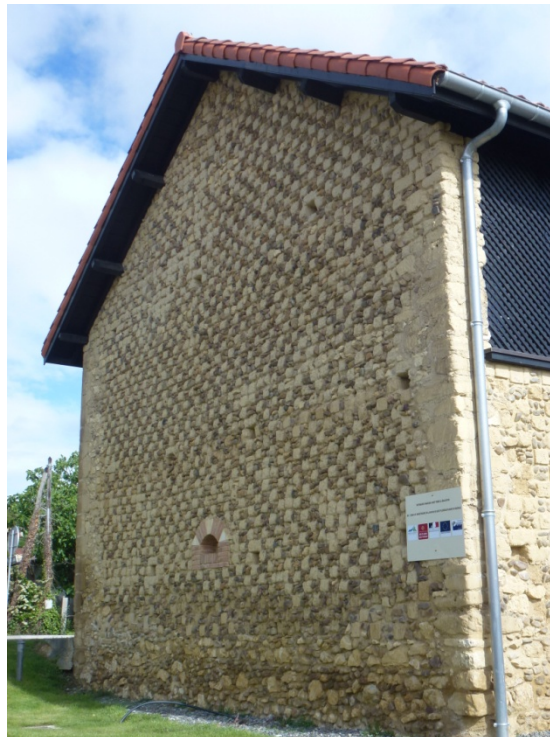
Fig.5 : Elancement très important de certains murs en damiers du Magnoac (© I. MOULIS)
