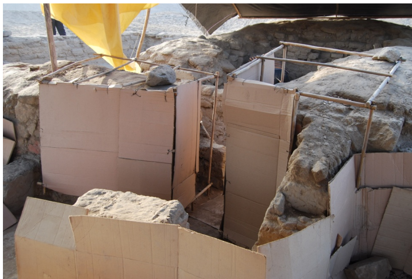
Figura 7: Protección provisional con estructuras de caña y cartón (Foto: M.J. Declerck).
