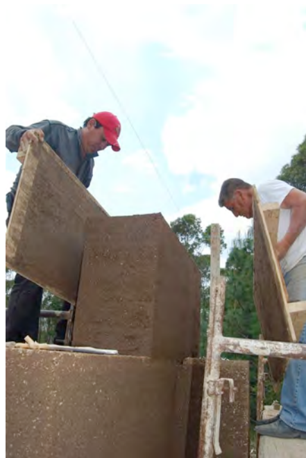
Figura 3. Encofrados ligeros que facilitan el proceso constructivo. Tlaxco, Tlaxcala. Foto: Luis Guerrero.
