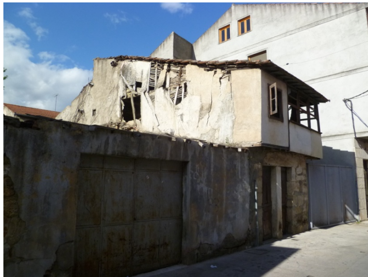
Figura 7: Entramado de pallabarro en la vivienda de tipo urbano.
