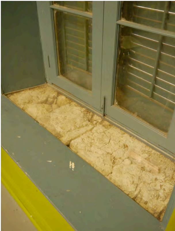
Fig. 7 : Couvent des Ursulines : détail du pisé (© Ricaud).
