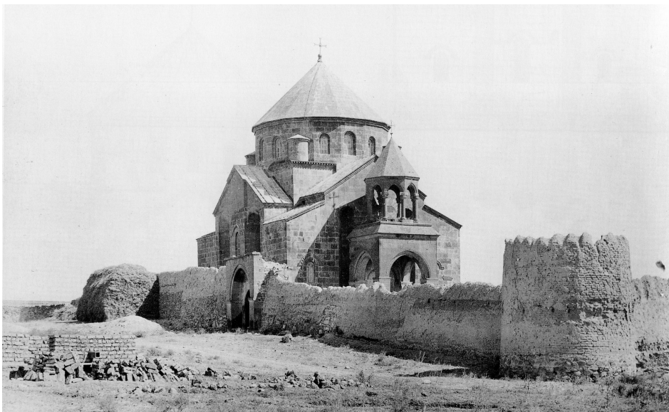
Fig. 4 : Enceinte en terre de l'église Sainte Hripsimé (VIIème s) et auto construction (à gauche).
