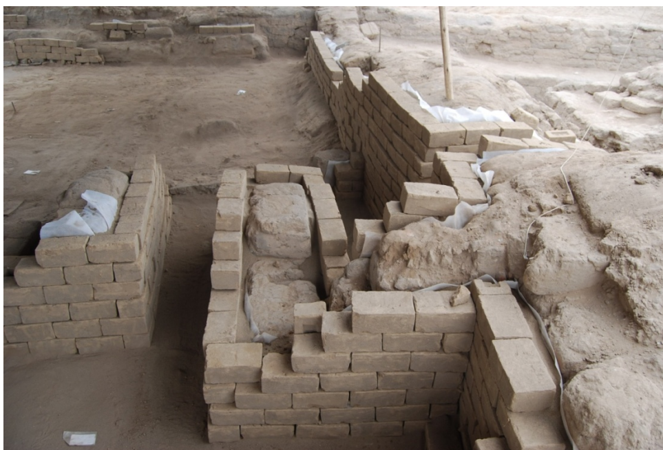
Figura 9: Reentierro de los muros (Foto: M.J. Declerck).
