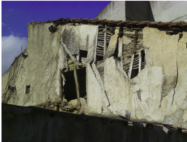
Figura 4: Detalle de un entramado de pallabarro.
