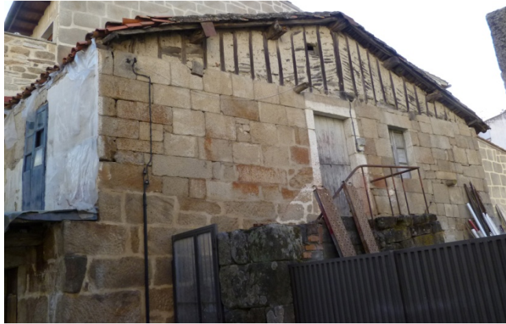
Figura 9: Detalle del entramado de madera para la formación del pincho de cubierta.
