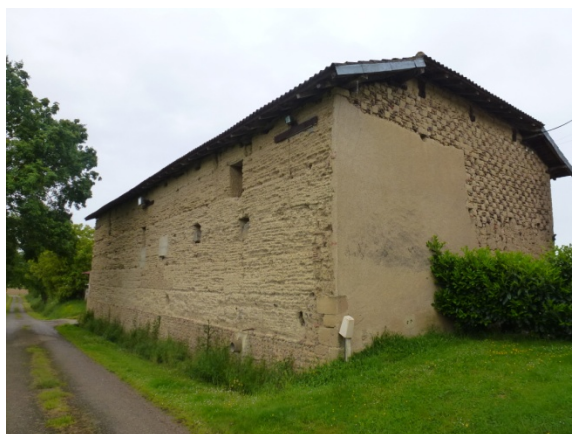
Fig.6 :Coexistence de pisé et de damiers : grange à Cuelas-Barrau (© I. MOULIS)
