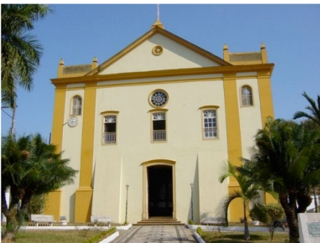
Fig.1- Fachada de la iglesia. Agosto 2005.
