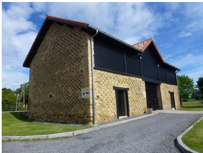
Fig.1 : La grange de Carrole, à Castelnau-Magnoac (Hautes-Pyrénées) - © I.MOULIS
