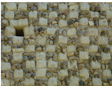
Fig.1. :Appareillage d'adobes et galets des constructions en damier du Magnoac (© I. MOULIS)
