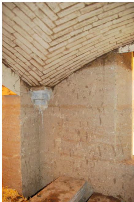
Figura 6. La bóveda de adobe fue diseñada por el Arq. Ramón Aguirre. Tlaxco, Tlaxcala, Foto: Luis Guerrero.
