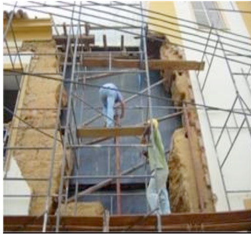
Fig. 4- Finalización de los trabajos de demolición del área colapsada. Enero 2006
