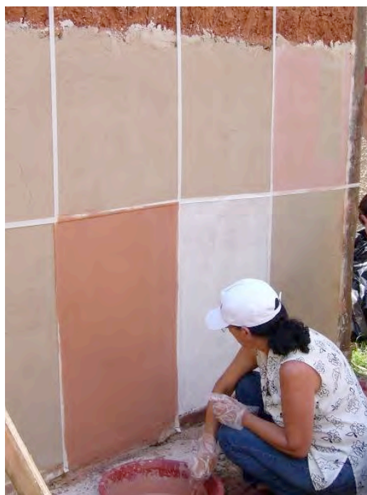
Figure 5. Mise en oeuvre de la peinture pendant la formation. Photo o3L (octobre/2009).
