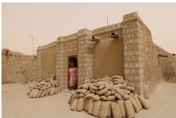
Une des maisons réhabilitée à Tombouctou
