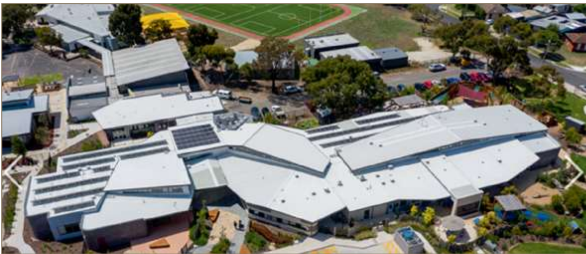
Figure 3. Vue aérienne du Korayn Birralee Family Centre , avec connexion au Northern Bay P-12 College (Image gracieusement fournie par Brand Architects. Photographie par Blue Tree Studios)
