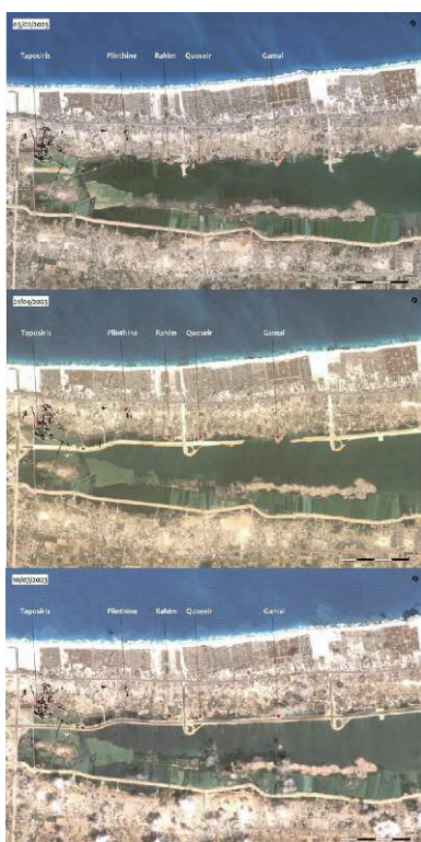
Fig. 6. Évolutions de la construction du nouveau réseau routier le long du lac Mariout entre février et juillet 2023 (MOM, J. Caverio d'après Copernicus Sentinel Data 2023).
