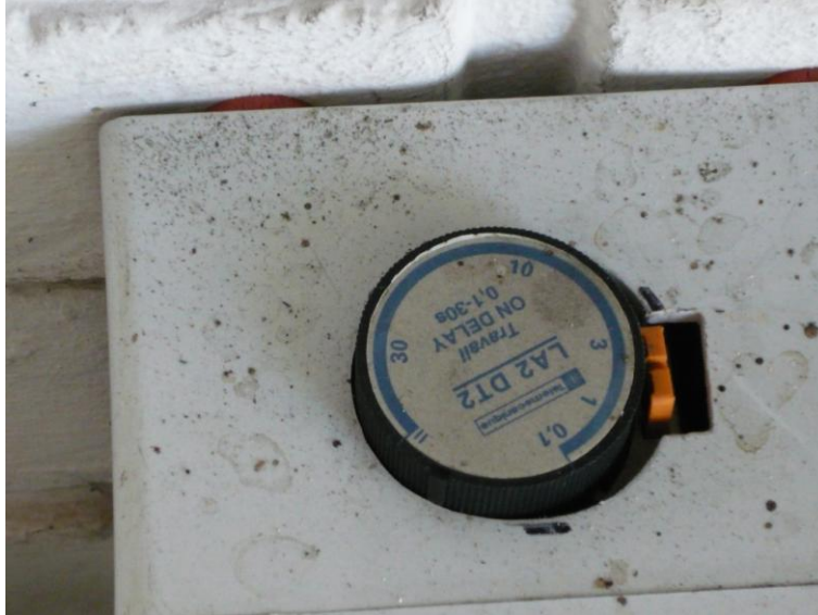
Photo 4. Découpe de la face supérieure de la boîte plexo destinée à laisser passer la molette de réglage des temporisations.
