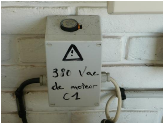
Photos 7 et 8. Boîtier de commande de l'électrovanne. A l'intérieur du boîtier, de gauche à droite : le contacteur surmonté de sa tête de temporisation, et le disjoncteur de protection de bobine et d'électrovanne.
