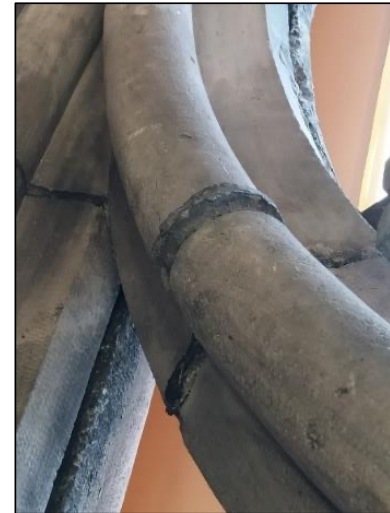
Scellement des pierres et absorption des contraintes
