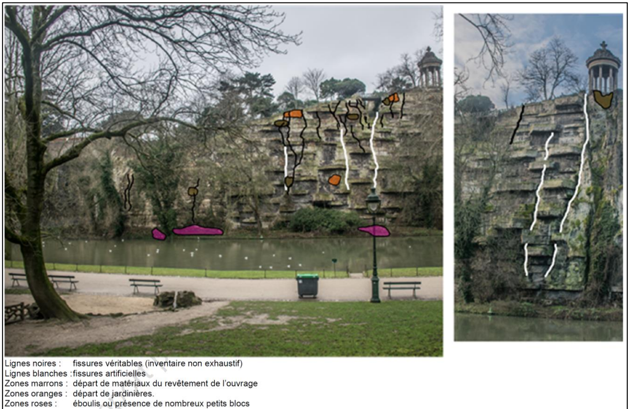
Figure 6. Vue de la paroi est de l'île présentant les principaux éléments de diagnostic du BRGM.
